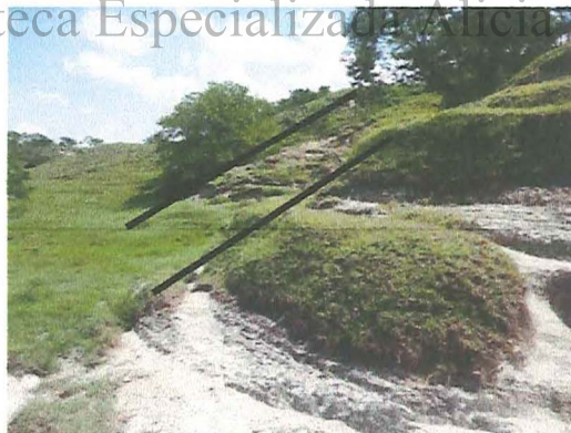
Fotografía 1.2.13 Procesos erosivos a los costados de las colinas medias disectadas
