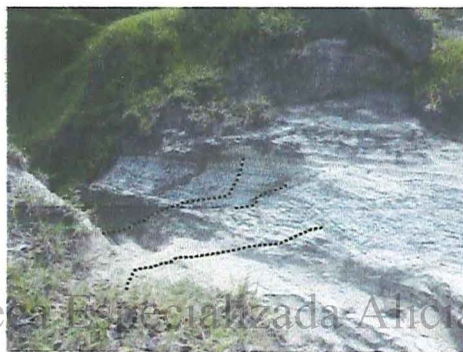
Fotografía 1.2.5. Ubicación de grietas a lo largo de afloramiento, ubicado en la zona del Clúster CJ
