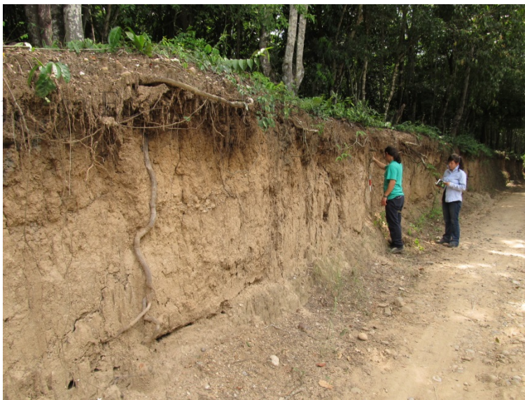
Fotografía 47. Inspección de perfiles en los alrededores del Área de Depósito 7.
