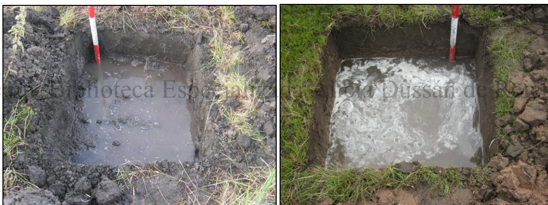
Fotografías 13 y 14. Suelos con alto nivel freático en las baquetas
