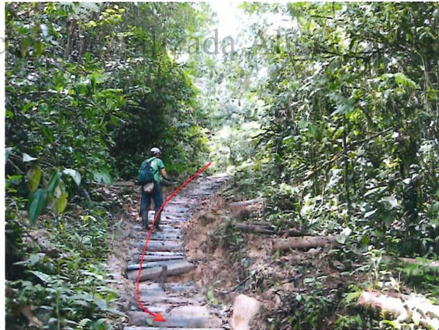
Foto N° 28 Aspecto de la vía propuesta sobre el Km 1+900
