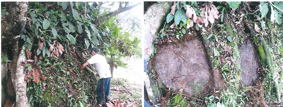
Foto N° 6. Proceso de limpieza de la roca situada en el eje de vía
