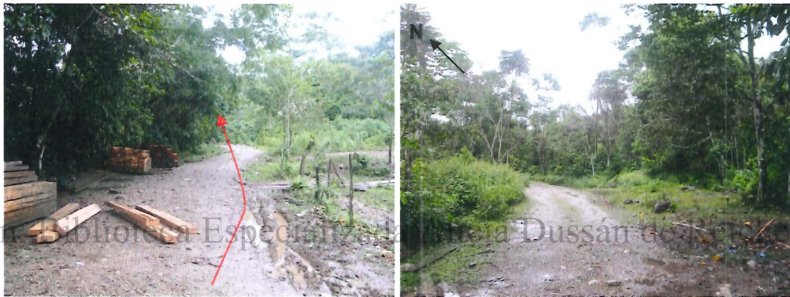
Foto N° 2. Vista hacia SW y NE respectivamente del inicio de la vía propuesta. El vector señala la primera propuesta de vía que se dirige al puente que da acceso a la escuela del Alto Vides. El eje de la vía atraviesa en este punto el río Vides.
