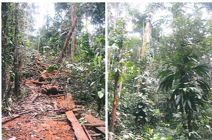
Foto N° 19. Aserrio sobre el km 2+700 y cobertura vegetal sobre la abscisa mencionada.
