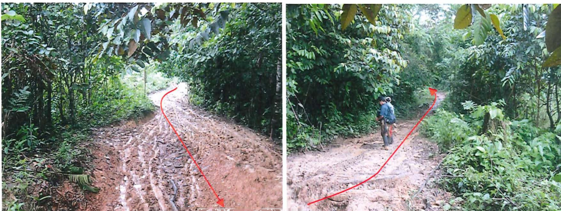
Foto N° 13. Dirección de la vía en el km 1+400
