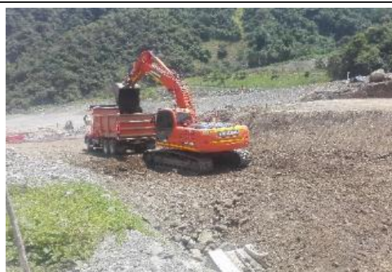
Fotografía 5-33. Excavación de terrazas en área de estación de combustible.
