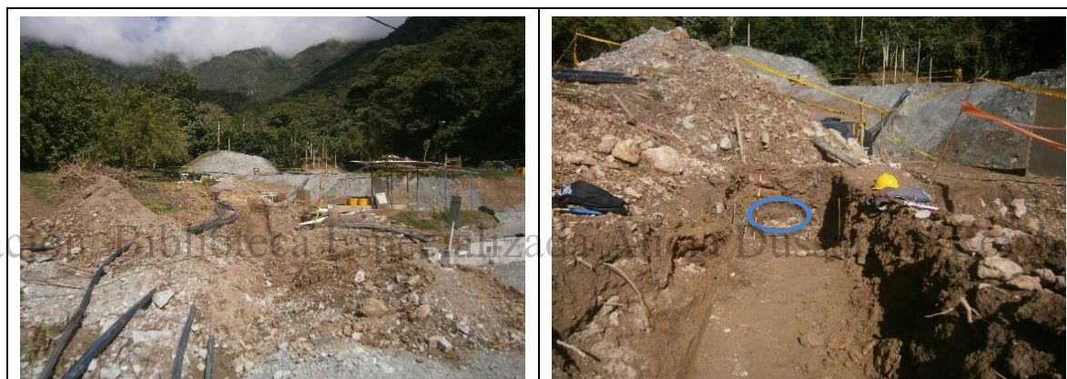
Fotografía 6-1. Panorámica de la zona donde se recuperaron las evidencias.
