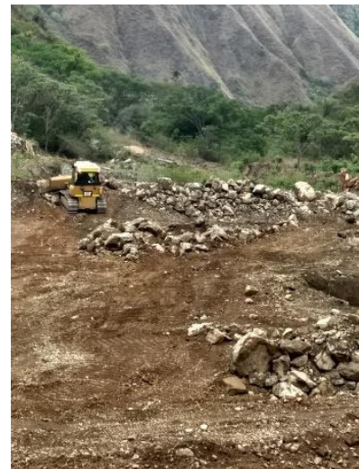
Fotografía 5-35. Levantamiento de capa orgánica parte baja Planta de Tratamiento de Aguas
