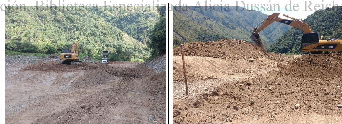
Fotografía 5-60. Conformación de jarillones. Canal La Bermejala
