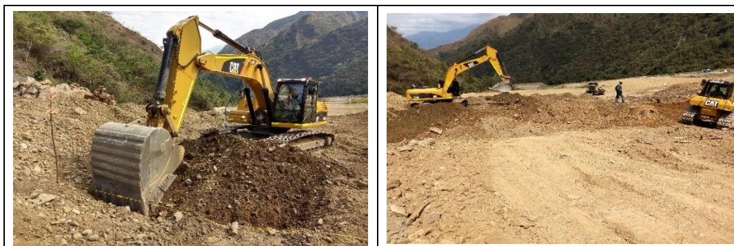
Fotografía 5-12. Excavaciones en Ed. Lixiviados, DCC y reactivos
