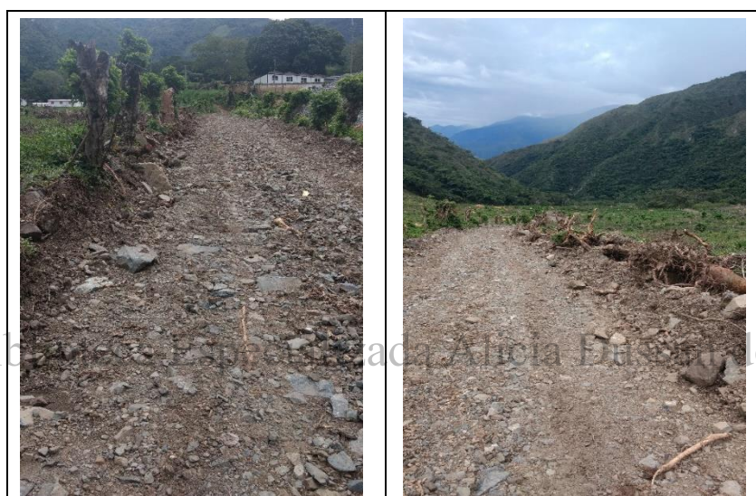
Fotografía 5-57. Vía de acceso a los frentes de trabajo del canal La Bermejala
