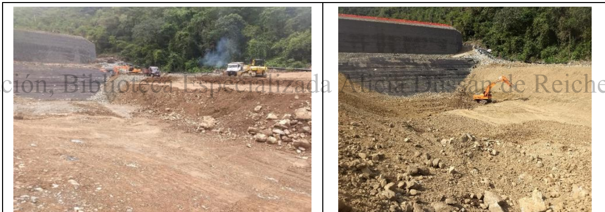
Fotografía 5-39. Excavaciones a profundidad en Pileta de compensación
