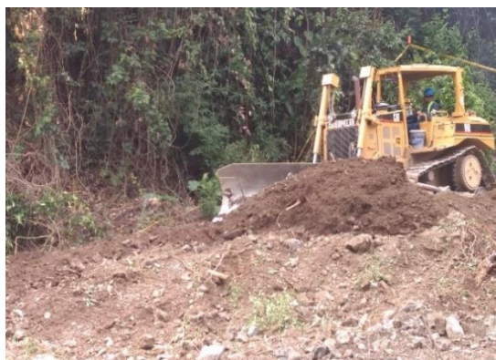
Fotografía 5-58. Excavación y descapote en zona del canal La Bermejala.
