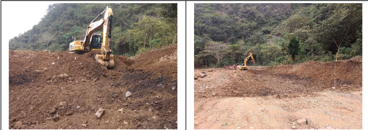
Fotografía 5-13. Excavaciones En El Canal Naranjo – Sauzal
