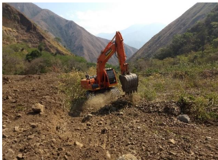
Fotografía 5-35. Levantamiento de capa orgánica parte baja Planta de Tratamiento de Aguas
