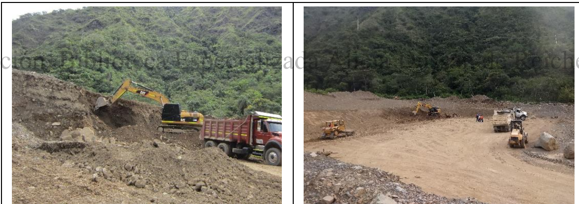
Fotografía 5-46. Excavaciones y conformación de plataforma C1.
