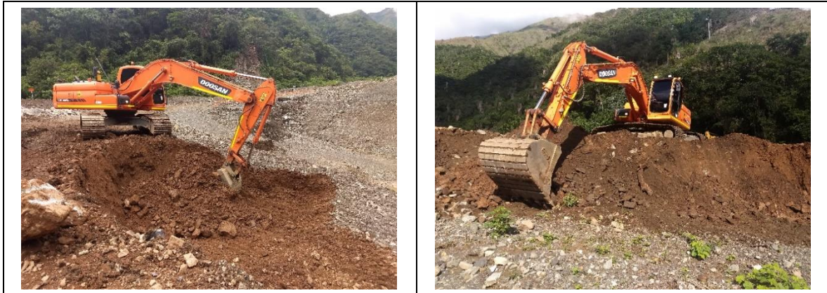
Fotografía 5-38. Excavaciones pileta de compensación.
