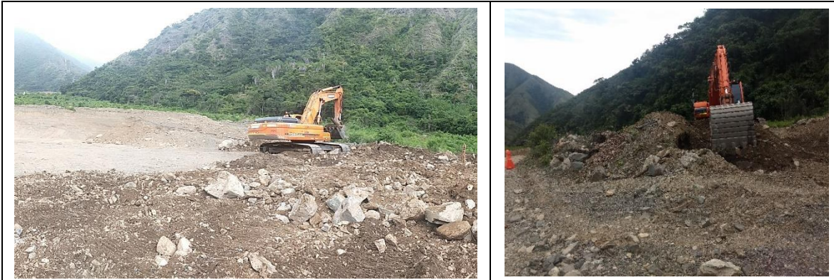
Fotografía 5-45. Área destinada para campamentos celda de relaves 3. Excavación y descapote Plataforma C3
