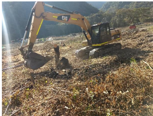
Fotografía 5-20. Levantamiento de capa orgánica. Estación de cargue
