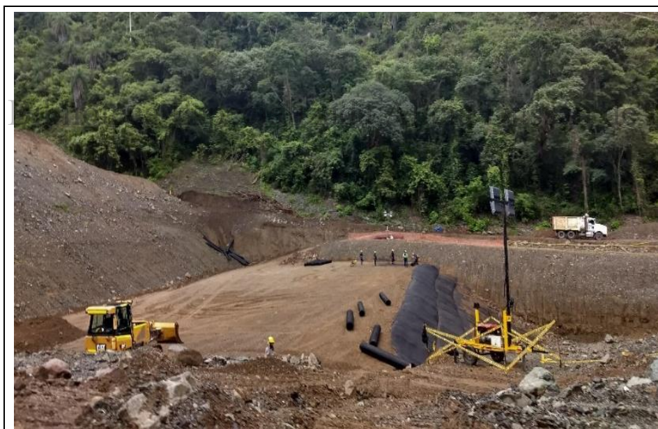
Fotografía 5-36. Conformación de muro de material. Planta de Tratamiento de Aguas
