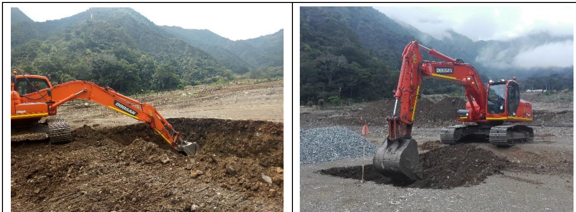
Fotografía 5-22. Excavación de filtro de relaves
