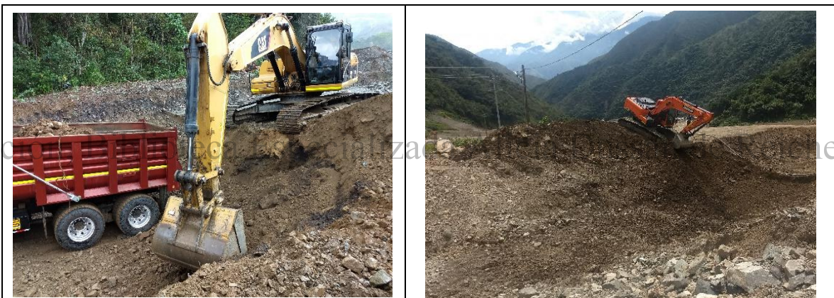
Fotografía 5-18. Excavación, cargue y perfilación Canal Naranjo – Sauzal
