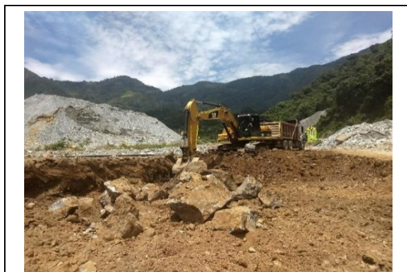
Fotografía 5-25. Excavación edificio Brigada de Rescate
