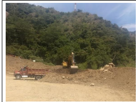
Fotografía 5-26. Excavación y cargue en depósito de orgánicos
