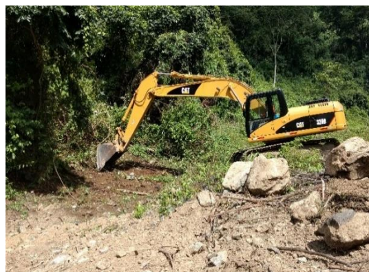
Fotografía 5-58. Excavación y descapote en zona del canal La Bermejala.
