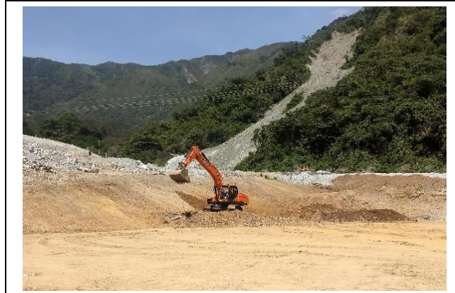
Fotografía 5-11. Excavación en zona de vestidores, lavanderías y parqueadero
