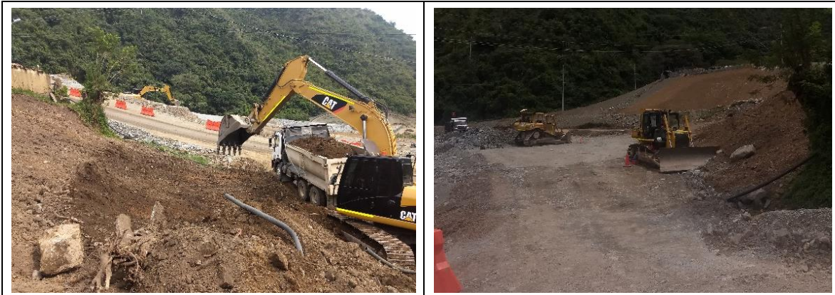
Fotografía 5-30. Excavación y lleno. Oficinas CNL
