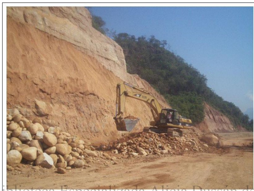
Foto 37: Seguimiento efectuado a las excavaciones realizadas en una de las terrazas altas aledañas al Río Sumapáz. Variante de Melgar. Km 97+ 870 a 98+ 870.
