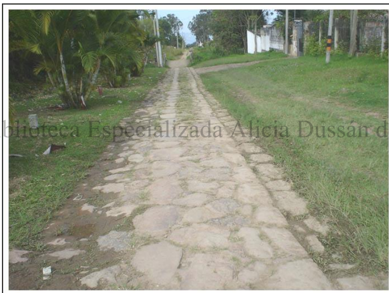
Foto 32: Camino empedrado que empieza en la localidad de Fusagasugá y termina en la vía que conduce de Arbeláez a San Bernardo, cerca al Río Cuja. Área de afectación indirecta Variante de Fusagasugá
