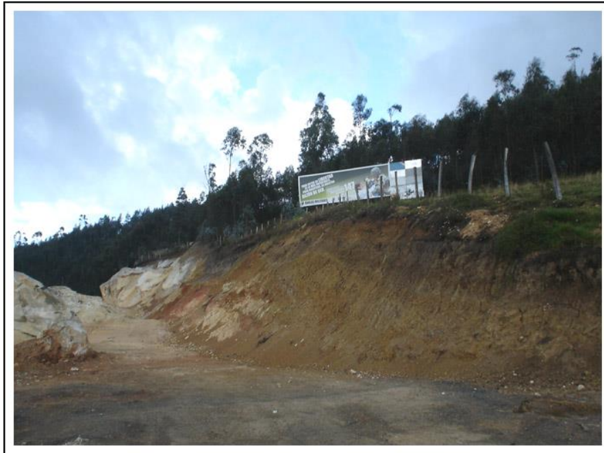
Foto 2: Perfil excavación efectuada para la adecuación de la doble calzada Bogotá – Girardot en el Km 19 + 300 a 19 + 500. Monitoreo Arqueológico.
