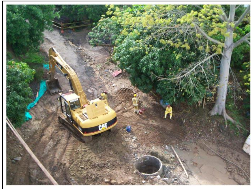
Foto 50: Seguimiento efectuado a las remociones de tierra para la construcción del Puente sobre el Río Magdalena. Km 119. Tramo El Paso- San Rafael
