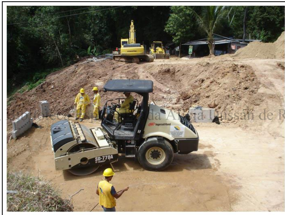
Foto 40: Seguimiento efectuado a las remociones de tierra efectuadas en el sector puntual del Km 112+ 700 a 112+ 800, para la ampliación de la doble calzada Bogotá – Girardot. Tramo Melgar – El Paso
