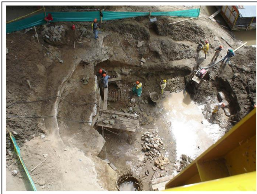
Foto 51: Seguimiento efectuado a las excavaciones manuales para los pilotes del Puente sobre el Río Magdalena. Km 119. Tramo El Paso – San Rafael.
