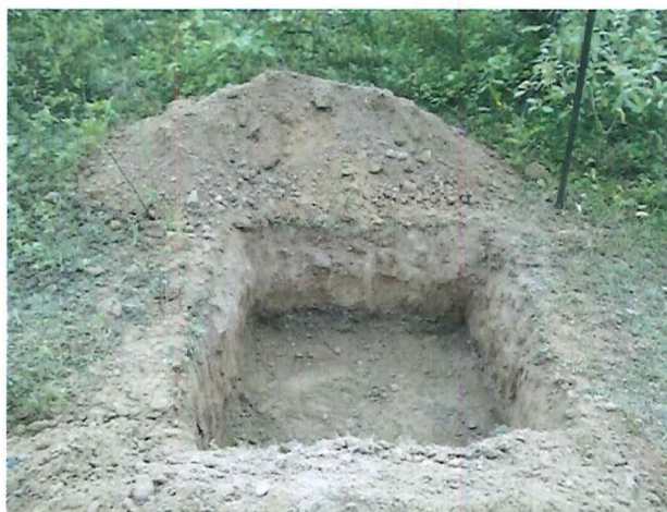
Fotografía 1 Sondeo en área de contrapozo Nunda SW
