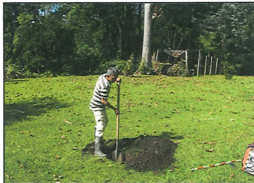
Foto 35, 36 y 37. Apertura de Pozos en UIA3Y2-Etapa2.
