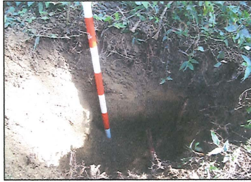
Foto 59. Pozo de Sondeo 45.
