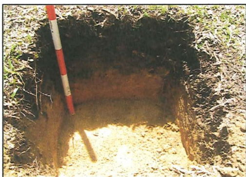
Foto 22. Pozo de sondeo 6
