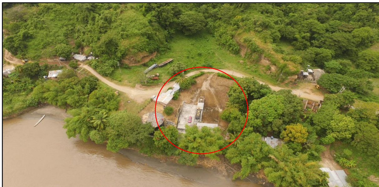
Figura 5. Fotografía aérea del predio destinada para el proyecto. En su interior, se nota las construcciones y modificaciones que se le han hecho al mismo a inicios de los años 90.
