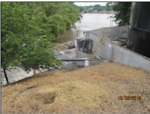
Figuras 14 y 15. Elaboración de los pozos de sondeo proyectados sobre el área terrestre del Muelle
