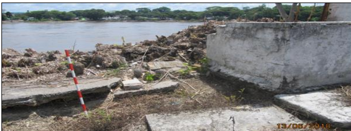
Figura 1. Aspecto general del área donde se acondicionará el muelle sobre el río, detalle de sus construcciones y río Magdalena al fondo. Fuente: Molano (2018).
