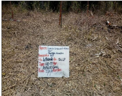
Fotografía 123 Aspecto general y actividades de excavación en la Torre 36, vereda Las Cañas
