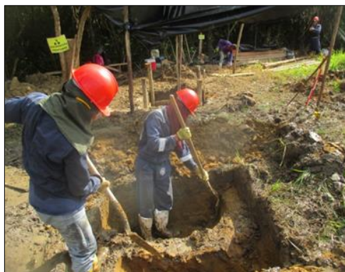
Fotografía 102 Actividades de excavación manual en la T141
