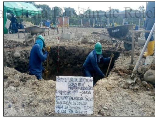
Fotografía 60 Registro de excavación a 1,3m
