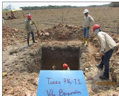
Fotografía 86 Actividades de excavación manual
