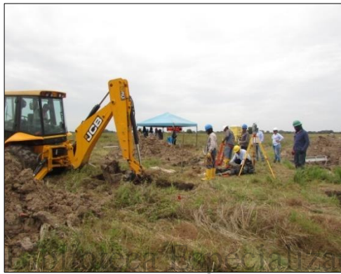
Fotografía 127 Aspecto general y actividades de excavación en la Torre 53, vereda San Francisco
