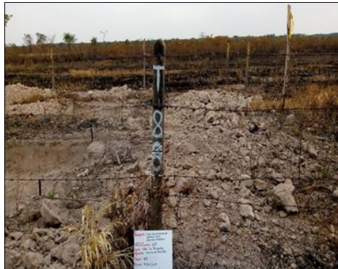
Fotografía 89 Aspecto general del sitio de la Torre 88, vereda La Barquereña
