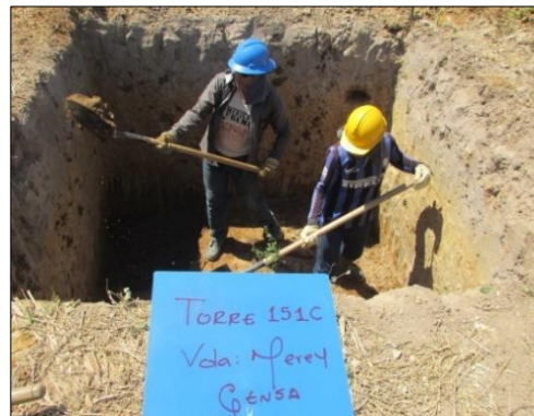
Fotografía 106 Actividades de excavación manual en la T 151
