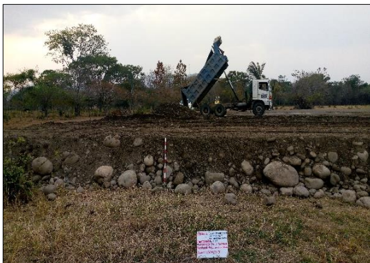
Fotografía 55 Adecuación del área de la subestación con crudo de río
