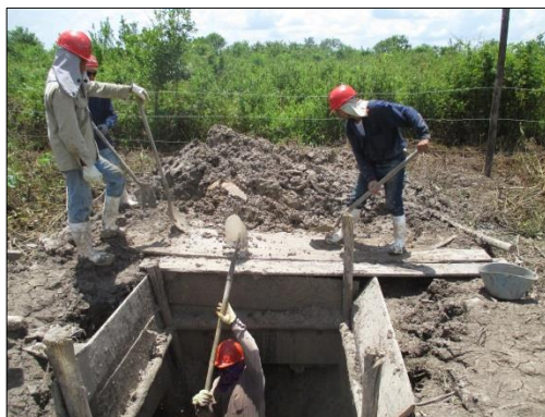
Fotografía 74 Actividades de excavación en base entibada
