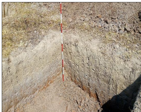
Fotografía 99 Registro a 1.2m en la excavación de la pata T119-D
