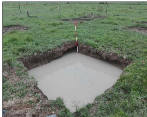
Fotografía 132 Excavación al 1,70m de profundidad
