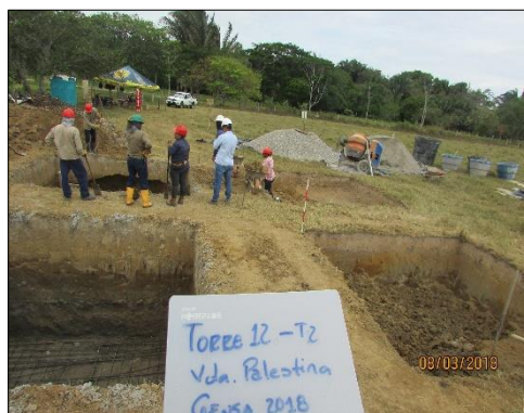
Fotografía 115 Aspecto general y actividades de excavación en la Torre 12, vereda Palestina
