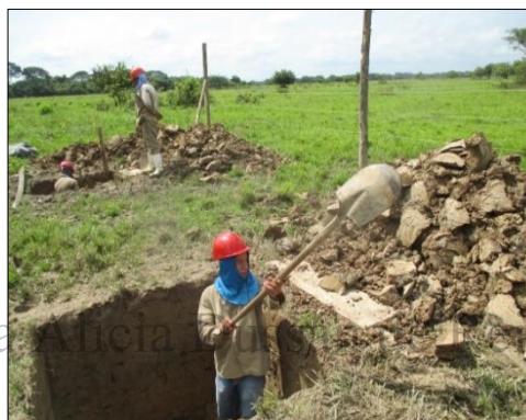
Fotografía 66 Actividades de excavación manual
