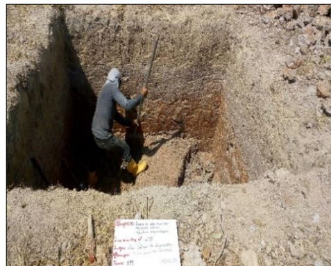
Fotografía 98 Actividades de excavación manual en la T119
