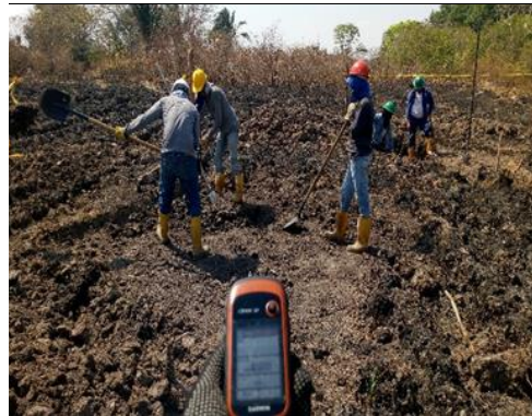
Fotografía 90 Actividades de excavación manual en la T88
