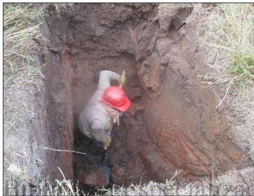
Fotografía 79 Continuidad de excavación manual hasta alcanzar los 2 m de profundidad
