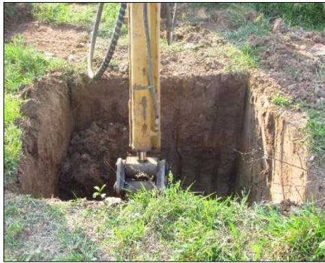
Fotografía 129 Aspecto general y actividades de excavación en la Torre 53, vereda San Francisco
