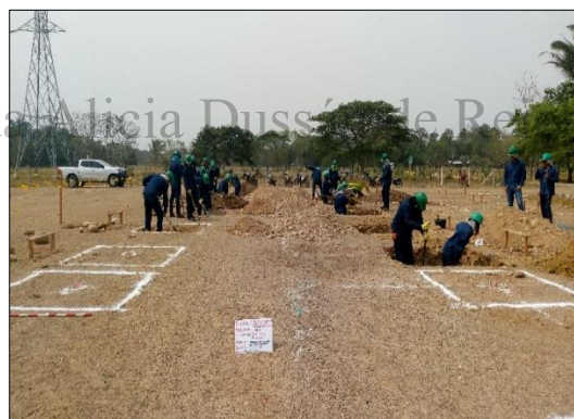
Fotografía 112 Actividades de excavación manual en el edificio de control
