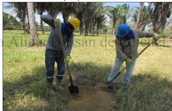
Fotografía 17 Relleno del pozo de sondeo registrado TR11-C
