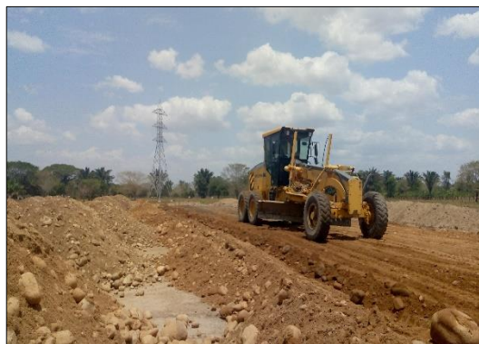
Fotografía 110 Adecuación del área de la subestación con crudo de río
