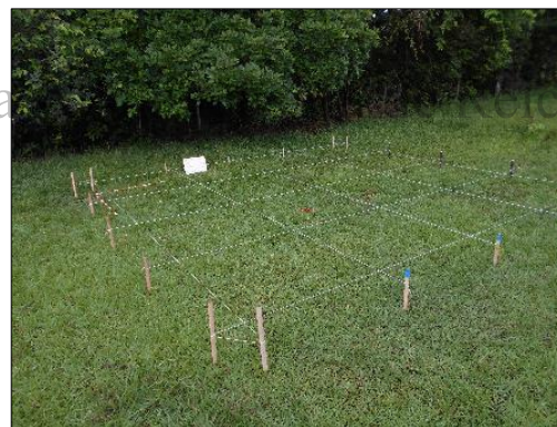
Fotografía 26 Corte establecido en la Torre 33
