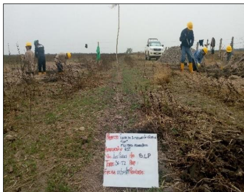
Fotografía 121 Aspecto general y actividades de excavación en la Torre 36, vereda Las Cañas
