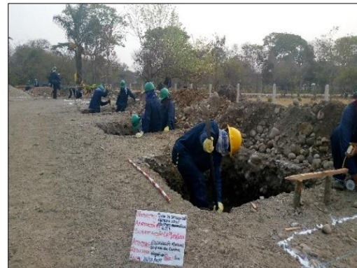
Fotografía 58 Actividades de excavación manual a 1m en el edificio de control
