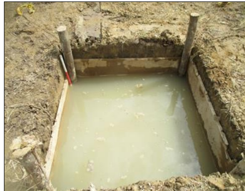
Fotografía 104 Registro de la excavación final
