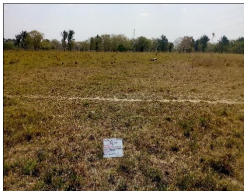
Fotografía 63 Aspecto general del sitio de la Torre1, dentro de la Subestación La Yopalosa
