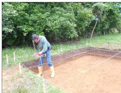
Fotografía 40 Pruebas de barreno en el corte de la Torre 33
