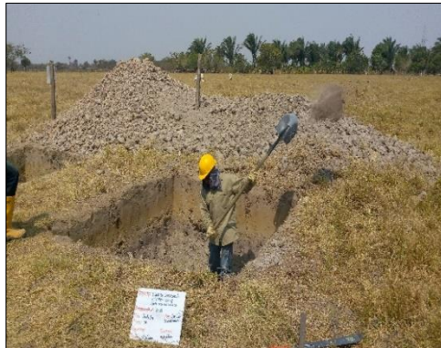
Fotografía 119 Aspecto general y actividades de excavación en la Torre 31, vereda Santa Ana
