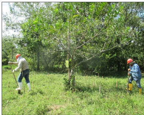
Fotografía 70 Inicio de actividades de excavación manual
