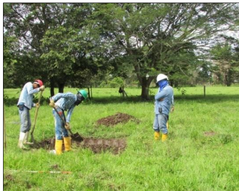
Fotografía 125 Aspecto general y actividades de excavación en la Torre 53, vereda San Francisco
