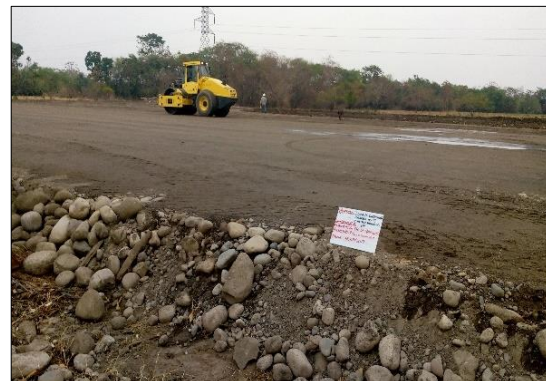
Fotografía 56 Proceso de compactación de suelos en la subestación La Yopalosa, sobre el área ya descapotada
