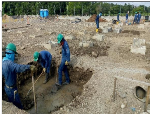
Fotografía 59 Inicio de actividades de excavación en la zona de pórticos
