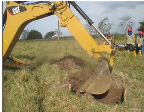
Fotografía 78 Actividades de excavación con máquina hasta el 1.80m
