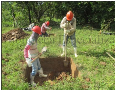
Fotografía 71 continuación de actividades de excavación manual
