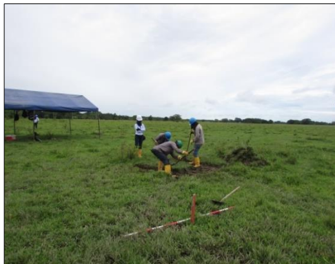
Fotografía 131 Inicio de actividades de excavación en la Torre 140
