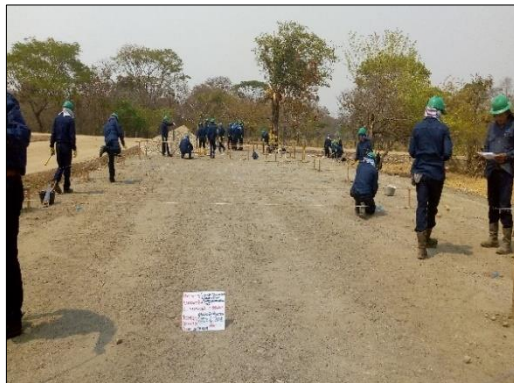
Fotografía 57 Adecuación en la zona del edificio de control
