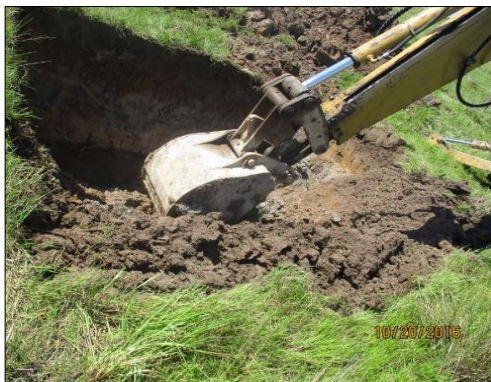
Fotografía 141 Revisión de suelos removidos en la Torre 230, Santa María del Loro
