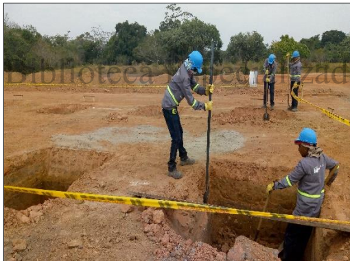
Fotografía 145 Actividades de excavación manual en el edificio de control
