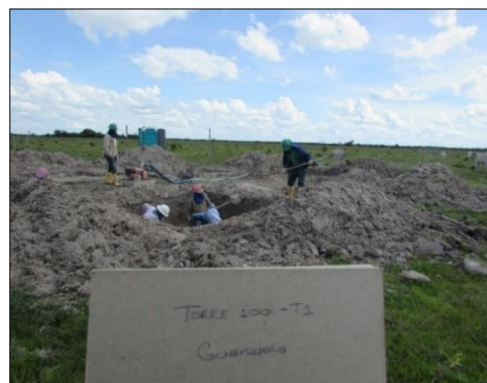
Fotografía 94 Actividades de excavación manual en la Torre 100
