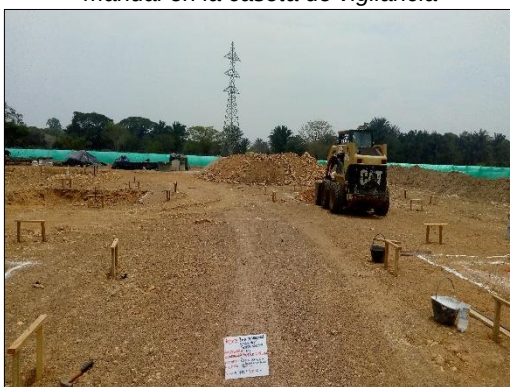
Fotografía 113 Actividades excavación con minicargador Bobcat en el área de pórticos
