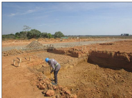
Fotografía 147 Actividades de excavación y nivelación en la zona del transformador
