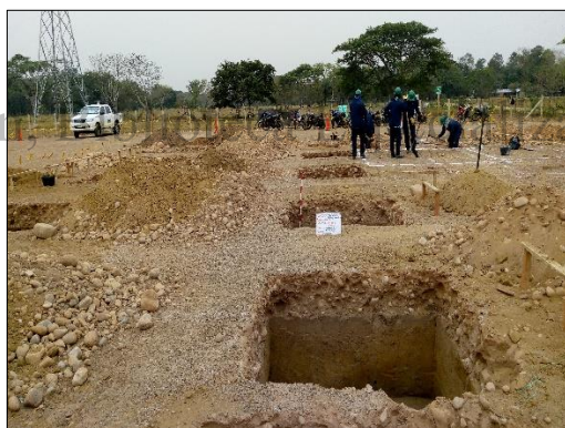
Fotografía 111 Actividades de excavación manual en la caseta de vigilancia
