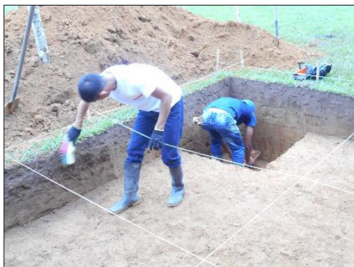
Fotografía 37 Profundización de la excavación en el lugar donde se emplazará la pata T33-A de la Torre 33
