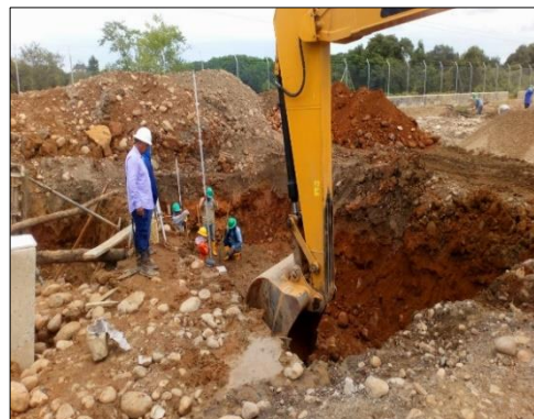
Fotografía 64 Actividades de con pala excavadora
