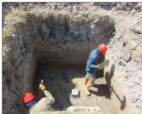
Fotografía 82 Actividades de excavación manual
