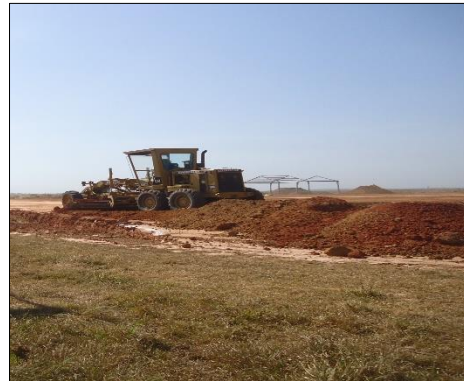
Fotografía 144 Actividades de descapote y en el lote de la subestación
