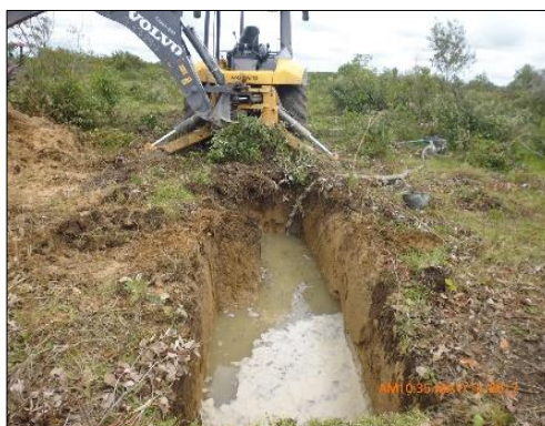
Fotografía 135 Excavación con máquina en la Torre 199, Bocas de Ulere
