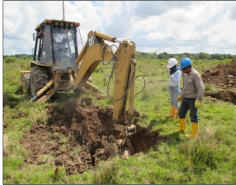
Fotografía 133 Excavación con máquina en la Torre 176, La Riverita
