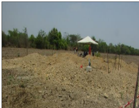
Fotografía 105 Aspecto general del sitio de la Torre 151, vereda El Meray
