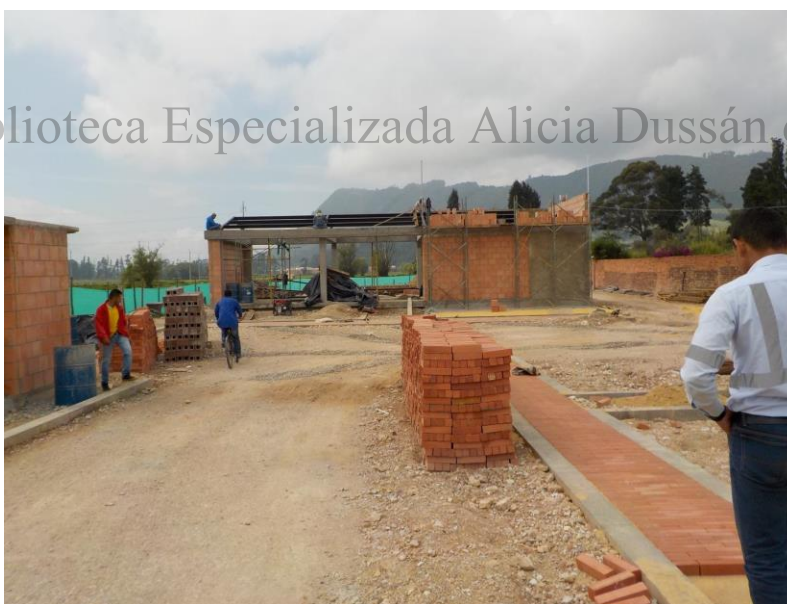
Foto 6-1 Construcción de Vivienda de Sala de Ventas
