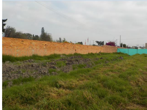
Foto 6-5 Zanja y suelo removido costado Occidental
