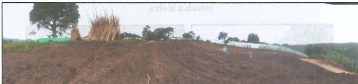
Foto 93: Panorámica del inicio de la remoción de la capa superficial de suelo.
