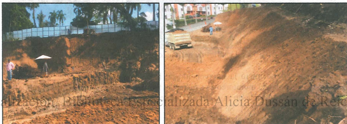
Fotos 86 y 87 : Actividades de los cortes con maquinaria pesada y apertura de nueva vía de entrada a la obra.
