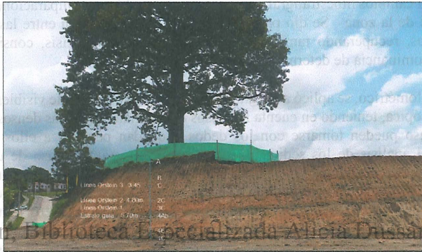
Foto 104: Corte que mira hacia el oeste en el segundo nivel de altura de la proyección de los escalones de la obra. Se destacan al menos dos líneas de óxidos de hierro y un estrato (paleosuelo?) gris oscuro.
