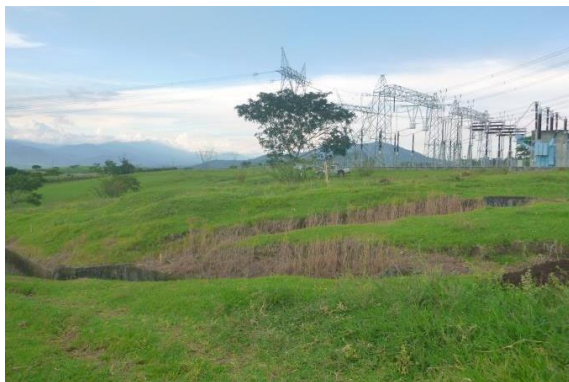
Fotografía 4. Panorámica del área donde se realizará la ampliación de la SE La Virginia. Al fondo se aprecia el patio 500Kv construido a finales de los 90's. Fuente: INGEDISA S.A. 2018
