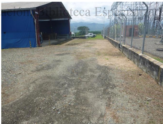
Fotografía 16. Edificaciones zona de bodegas. Fuente: INGEDISA S.A. 2018.
