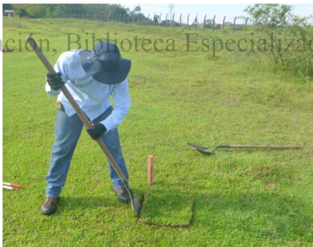
Fotografía 10. Localización y etapa inicial de excavación pozo de sondeos, área del Polígono de ampliación de la S.E. Fuente: INGEDISA S.A. 2018.
