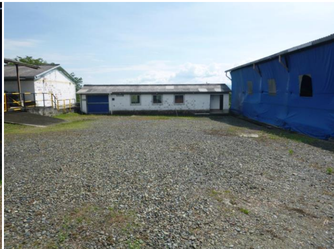
Fotografía 15. Detalle del suelo en la zona zona de bodegas. Fuente: INGEDISA S.A. 2018.
