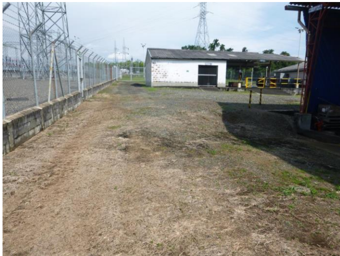
Fotografía 14. Zona de bodegas, área altamente intervenida. Fuente: INGEDISA S.A. 2018.
