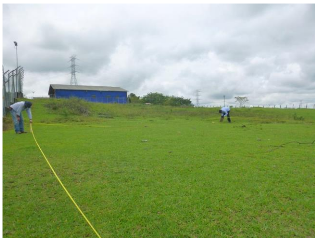
Fotografía 8. Trazado de la grilla, área del Polígono de ampliación de la S.E. Fuente: INGEDISA S.A. 2018.
