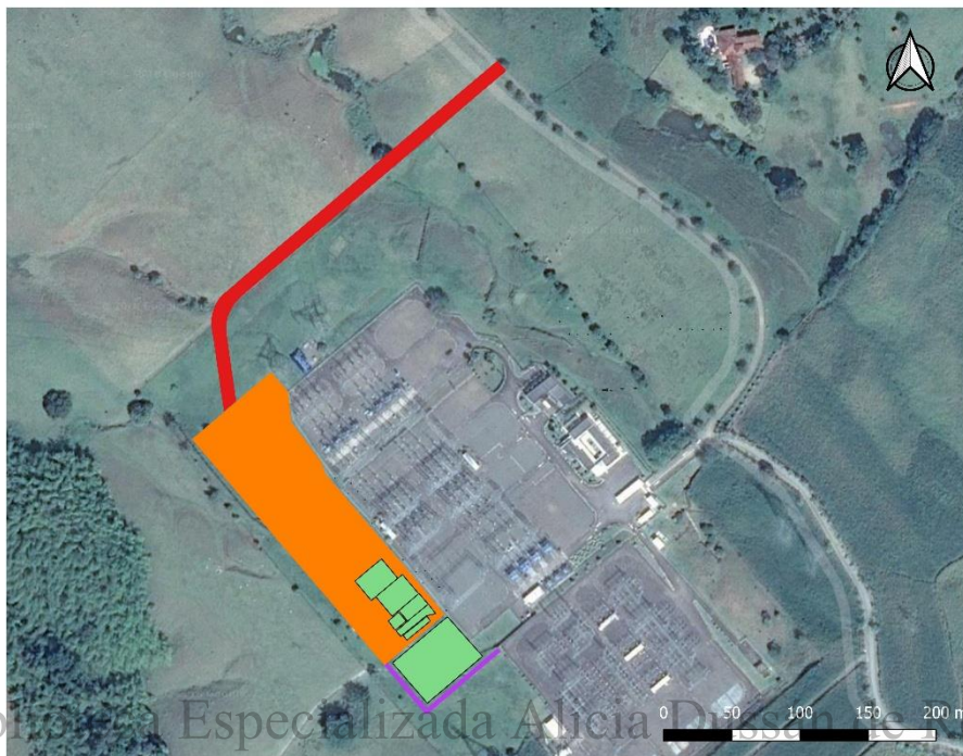
Figura 2. Polígono de intervención para la ampliación de la SE La Virginia. En rojo se aprecia el trazado de la vía de acceso temporal. En naranja se observa el polígono de ampliación de la SE a 500kV, y en lila el área destinada para el cerramiento. Las zonas coloreadas de verde corresponden a las bodegas y áreas no intervenidas por este proyecto. Fuente: INGEDISA S.A. 2018
