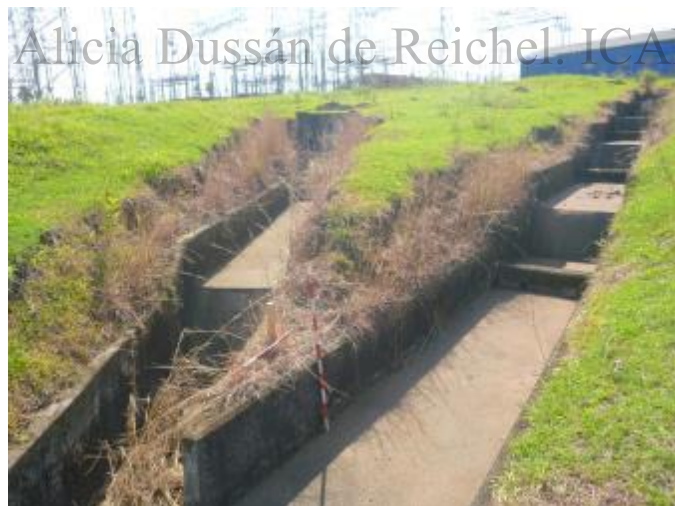
Fotografía 17. Localización del pozos de sondeo descartado G80, observe el canal de desagüe que cruza el predio del polígono de ampliación. Fuente: INGEDISA S.A. 2018.
