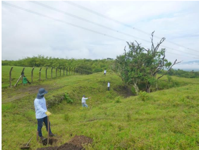
Fotografía 22. Pozos de sondeo descartados en el área del carreteable por hallarse en zonas muy intervenidas. Fuente: INGEDISA S.A. 2018.
