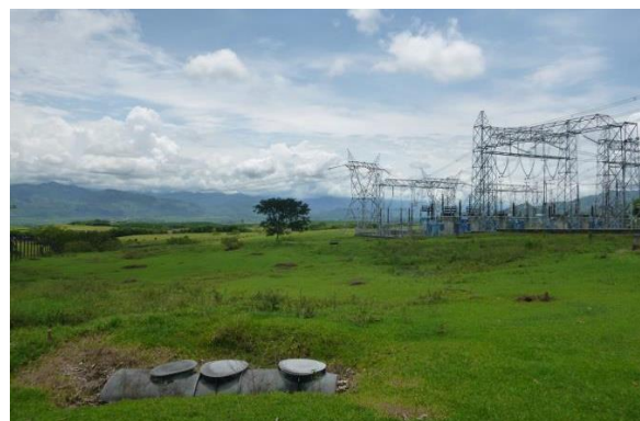
Fotografía 5. Panorámica del área donde se realizará la ampliación de la SE La Virginia. Al fondo se aprecia el patio 500Kv construido a finales de los 90's y en la parte inferior un tanque séptico instalado al momento de realizar la construcción de dicha SE. Fuente: INGEDISA S.A. 2018
