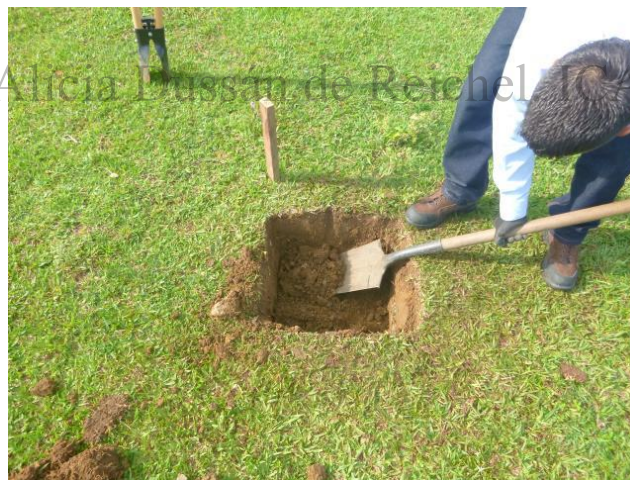
Fotografía 11. Proceso de excavación pozo de sondeo, área del Polígono de ampliación de la S.E. Fuente: INGEDISA S.A. 2018.
