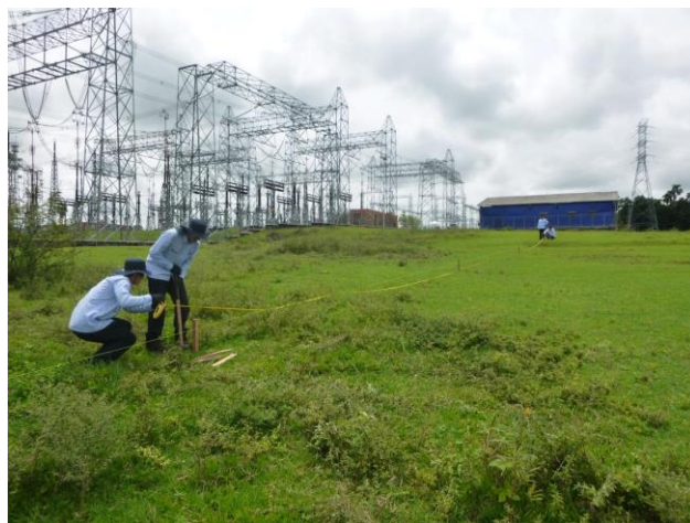
Fotografía 9. Trazado de la grilla, área del Polígono de ampliación de la S.E. Fuente: INGEDISA S.A. 2018.
