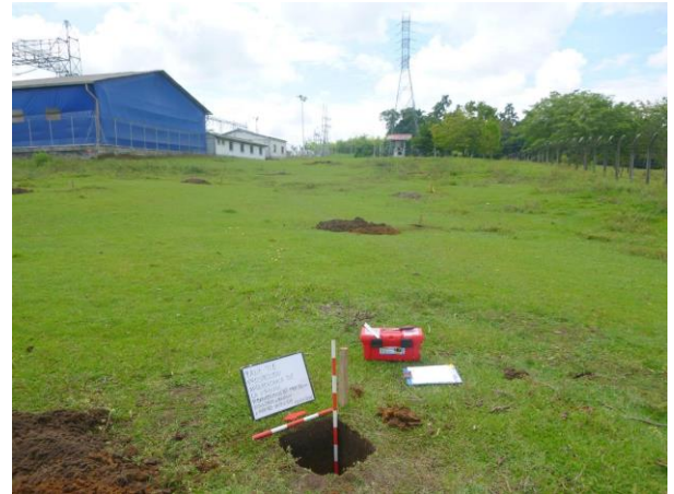
Fotografía 13. Registro de pozo de sondeo, área del Polígono de ampliación de la S.E. Fuente: INGEDISA S.A. 2018.
