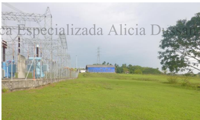
Fotografía 6. Panorámica del área donde se realizará la ampliación de la SE La Virginia. Al fondo se aprecia el área de bodegas construido a finales de los 90's. Fuente: INGEDISA S.A. 2018
