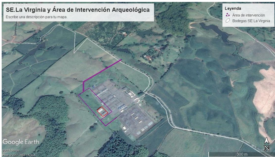
Fotografía 7. Fotografía satelital por sistema Google Earth de la Subestación La Virginia (Pereira, Risaralda). En lila se aprecia polígono de intervención para la ampliación de la Subestación en el marco del proyecto segundo refuerzo de red del área oriental: SE La Virginia a 500kV y en rojo el área con construcciones para bodega Fuente: INGEDISA S.A. 2018
