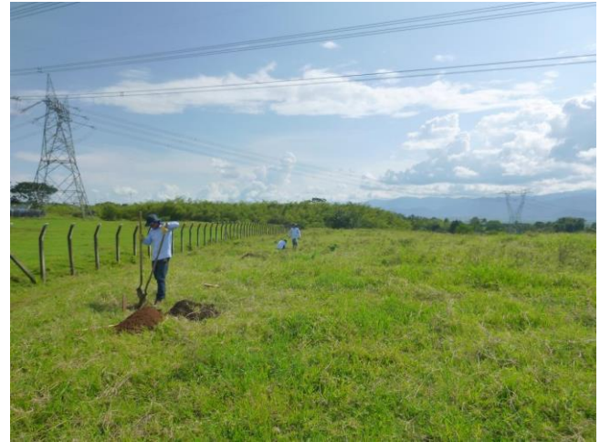
Fotografía 23. Proceso de excavación pozos de sondeo, área del carreteable. Fuente: INGEDISA S.A. 2018.
