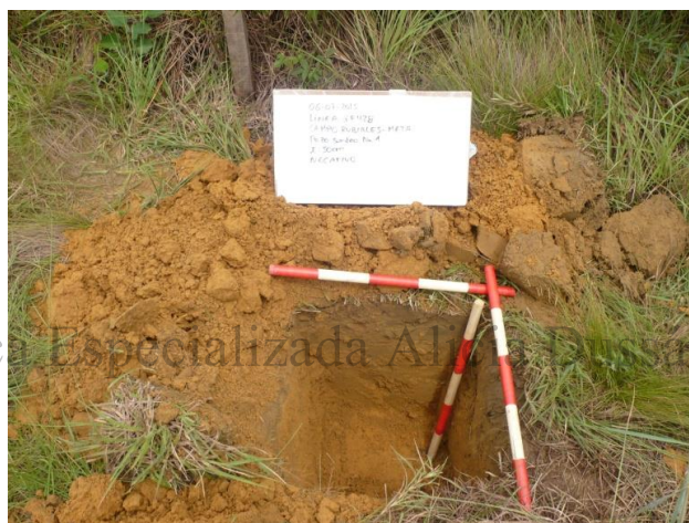
Foto 12. Pozo de sondeo No. 4 de la Línea de Flujo QF 428
