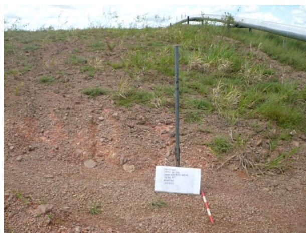
Foto 31. Vista de la Línea de Flujo QF 393.
