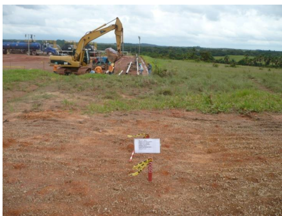
Foto 1. Hacia el Occidente se observa la plataforma sobre la cual va la línea Ambar 83D. Al fondo se ve el inicio, y en la estaca se ve el final del trazado, evidenciándose el suelo removido.
