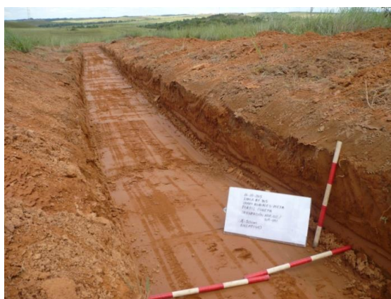
Foto 18. Perfil Occidental, sobre una cuneta por donde pasa de forma transversal la Línea de Flujo QF 405.
