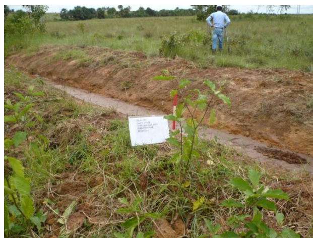
Foto 13. Cuneta que atraviesa el corredor central de la Línea de Flujo QF 428
