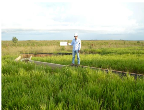
Foto 24. Donde finaliza la línea en el área intervenida de la plataforma de QF 142
