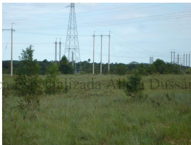
Foto 28. Hacia la parte final de la Línea de Flujo QF 429 se observan redes eléctricas.
