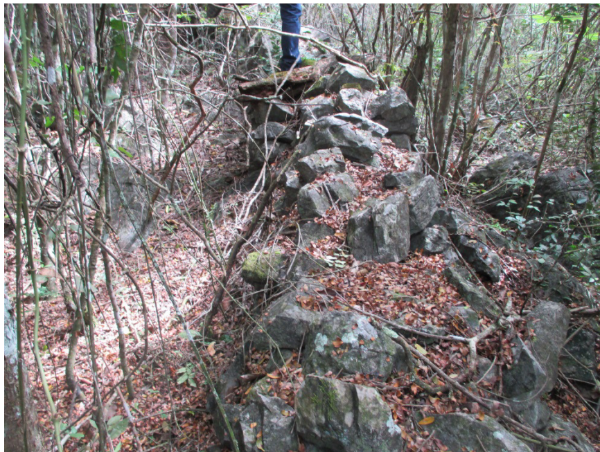
Fotografía 3.21 Muro de piedra que separaba antiguas haciendas
