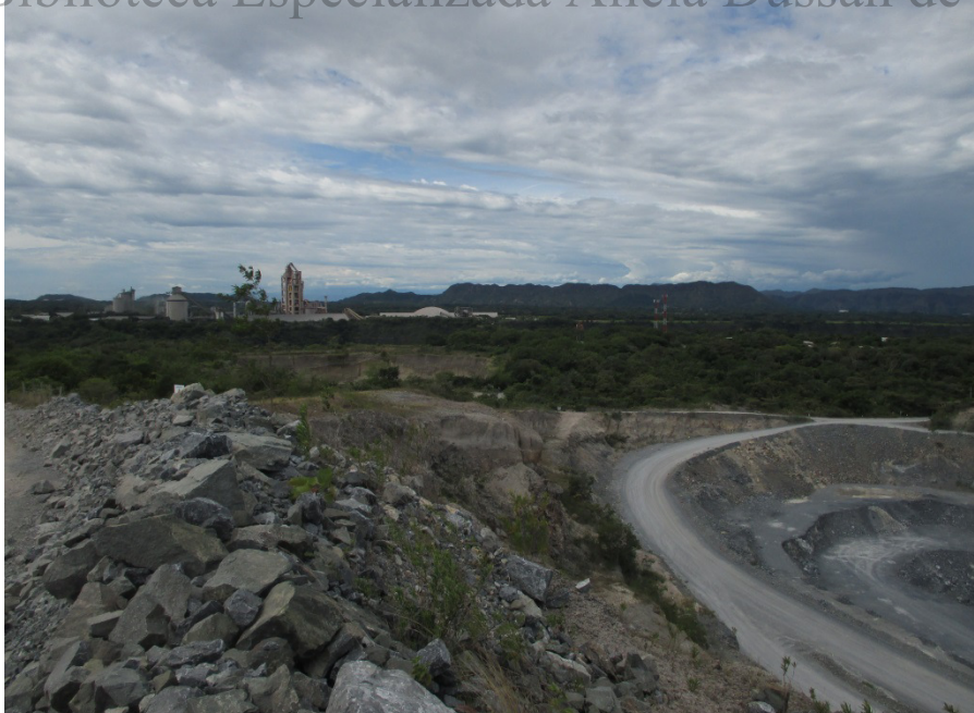
Fotografía 3.4 Panorámica de taludes excavados en el sector A2
