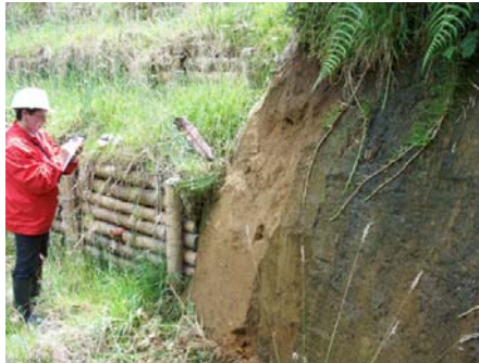
Fotografía 27. Observación de Taludes de plataformas adecuadas. Sobresale el Horizonte pardo amarillento, asociado a ceniza volcánica.
