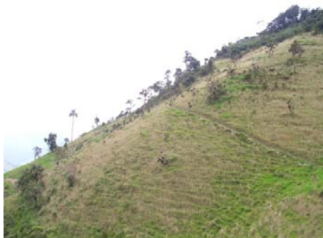
Fotografía 1. Pendientes continuas y pronunciadas sin adecuaciones antrópicas
