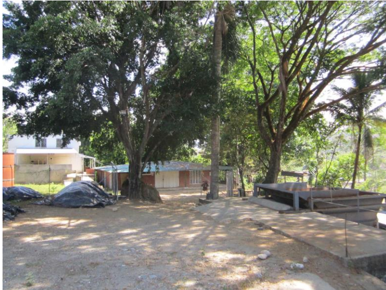
Foto 16. Espacio utilizado para alimentar tolva con materias primas
