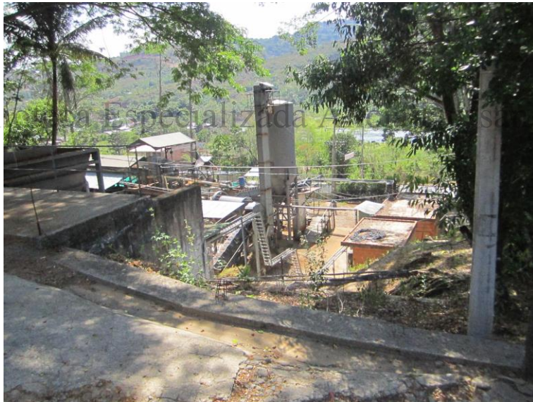
Foto 13. Zona sur de Planta de procesos, vista desde zona alta al sur-occidente.
