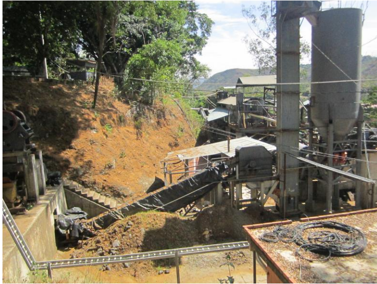
Foto 14. Adecuación de espacios para instalación de Planta.
