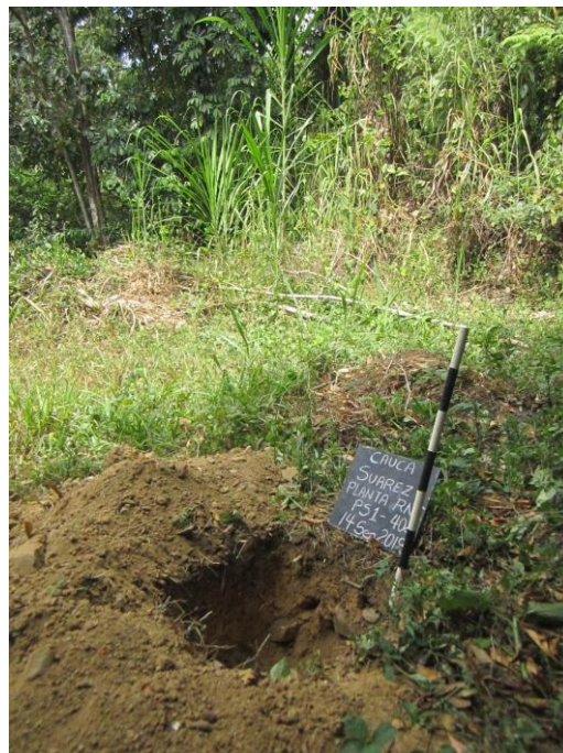
Foto 6. Pozo de Sondeo 1, sector nor-oriental del lote.
