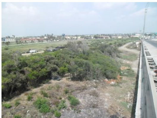
Fotografía 6 Vista del área 1 desde el Puente Pumarejo
