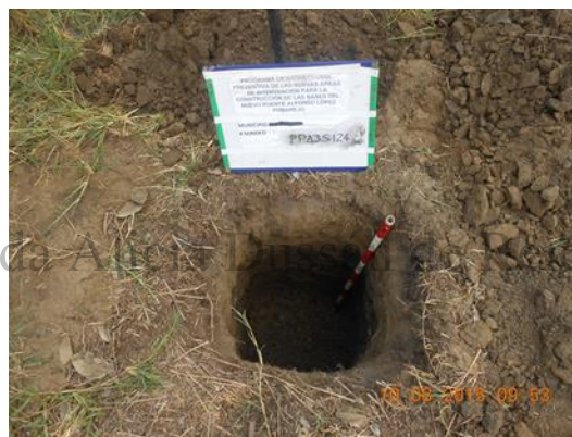
Fotografía 42 Vista de pozo de sondeo 124 realizado en el área 3
