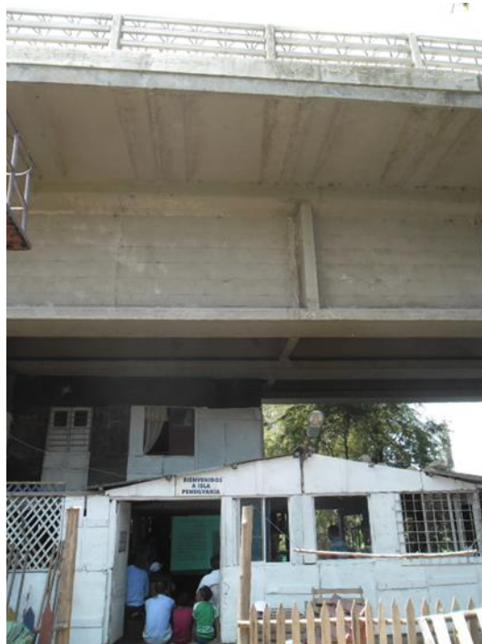
Fotografía 45 Vista de la casa donde se realizó la capacitación a los obreros
