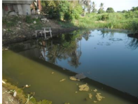
Fotografía 29 estanque construido con fines piscícolas
