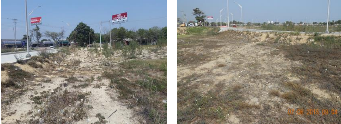
Fotografía 14 Sector intervenido donde se ubican las pilas 1 a 18
