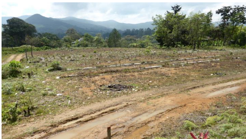
FOTO 33. MORFOLOGÍA DEL TERRACEO 1 PARA INSTALACIÓN DE VIVEROS
