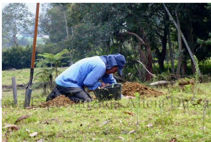
FOTO 14. EXCAVACIÓN DEL POZO DE SONDEO 17
