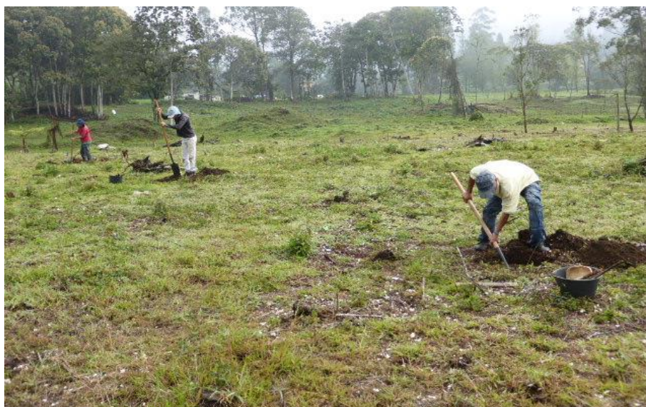
FOTO 22. EXCAVACIÓN DE SONDEOS 40 -41 -42
