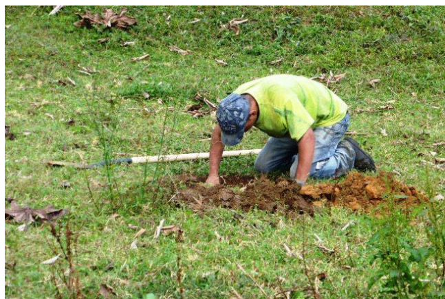
FOTO 12. EXCAVACIÓN DE SONDEO 16
