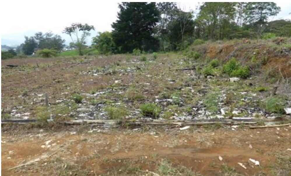
FOTO 35: MORFOLOGÍA DEL TERRACEO 3 PARA INSTALACIÓN DE VIVEROS
