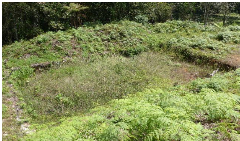
FOTO 38. DEPOSITO DE AGUA EN LA EXPLANACIÓN NORTE
