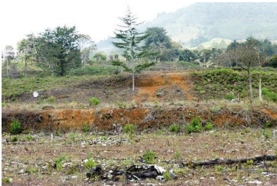
FOTO 37. ADECUACIONES ESCALONADAS PARA FORMAR TERRAZAS DE VIVIENDA Y ADECUACIONES PARA VIVEROS
