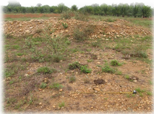
Fotografía 7. Acumulación de materiales extraídos de la excavación de las piscinas.
