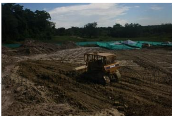
Foto 10. Proceso de relleno en UMGP2 Coordenadas N06,48599° y W74,42006°
