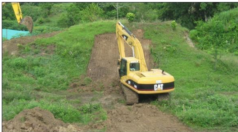
Foto 49. UMGP6 Remoción de capa húmica o descapote N06,48694° y W74,42086°
