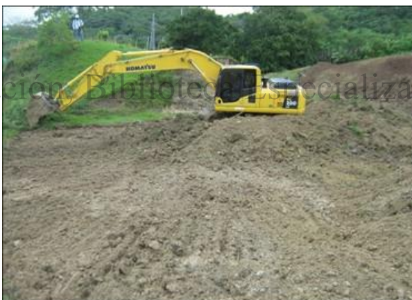
Foto 43. UMGP5 Remoción de capa húmica N06,48682° y W74,42129°
