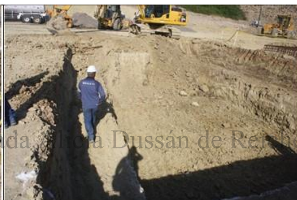
Foto 75. excavación base 2 de compresor N06,48618° y W74,42033°
