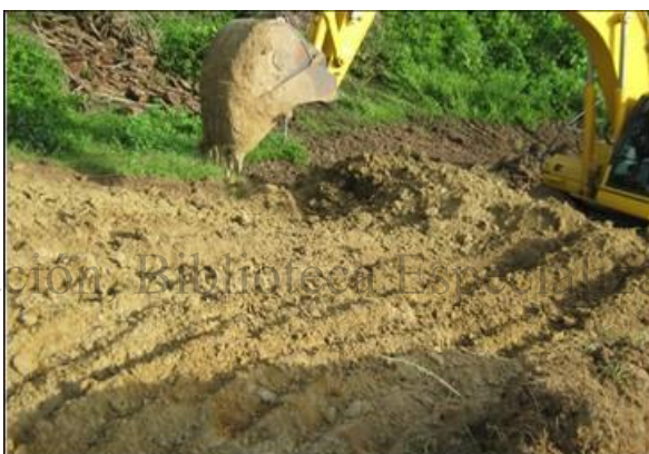
Foto 29. UMGP4. Inicio del descapote Coordenadas N06,48672° y W74,42027°
