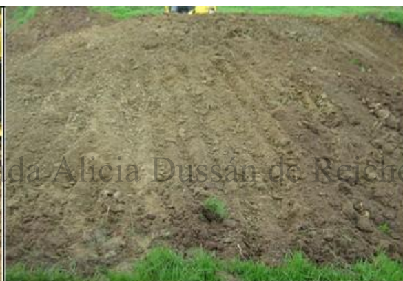
Foto 30. UMGP4. Sector descapotado de la cima y laderas de la colina Coordenadas N06,48679° y W074,42032°
