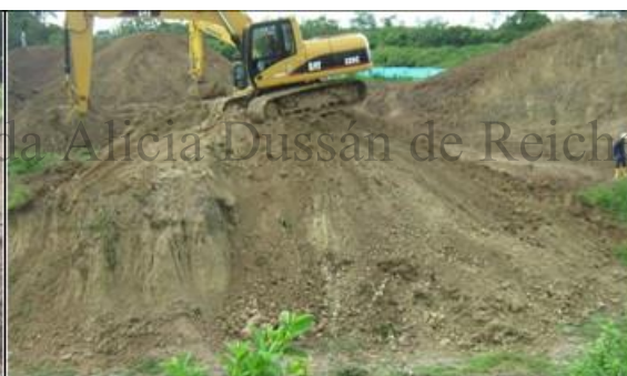
Foto 52. UMGP6 Excavación segunda capa 30-60 cm. N06,48694° y W74,42086°
