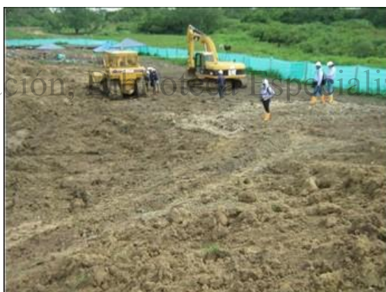
Foto 6. Actividad de relleno en UMPG2 coordenadas N05,48611° y W74,42057°
