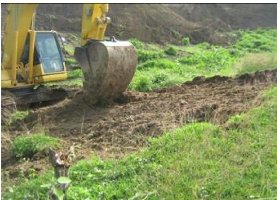
Foto 27. UMGP4. Inicio del descapote Coordenadas N06,48673 y W74,42040
