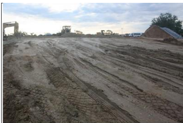
Foto 65. Sector con relleno donde se ubicaba UMGP8 N06,48724° y W74,42042°
