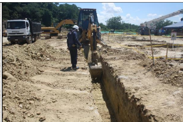
Foto 79. excavación zanja de ductos 2 N06,48630° y W74,42058°
