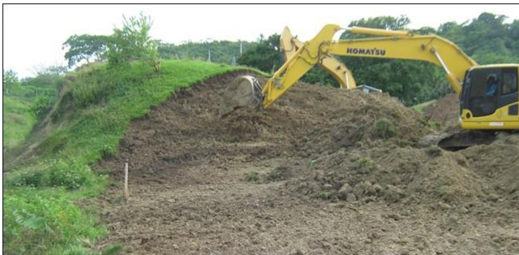
Foto 50. UMGP6 Remoción de capa húmica o descapote, profundidad 0-30 cm. N06,48694° y W74,42086°
