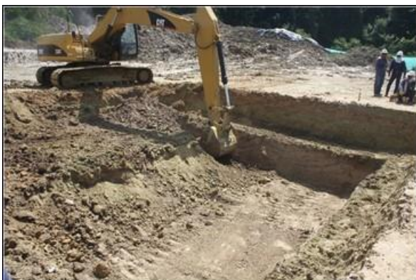
Foto 72. proceso de excavación base 1 de compresor N06,48606° y W74,42024°
