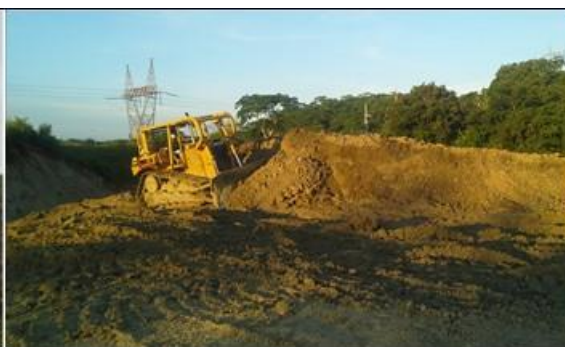
Foto 54. UMGP6 Aplanamiento final N06,48694° y W74,42086°
