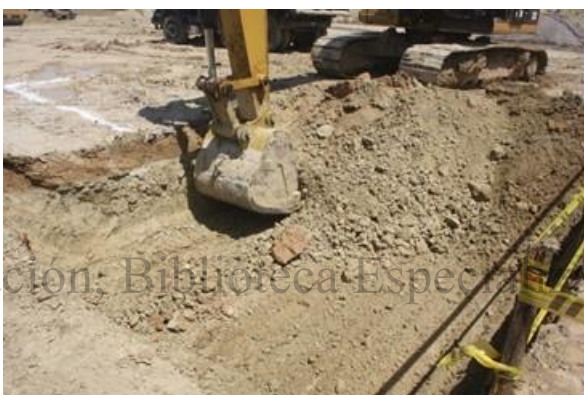
Foto 74. excavación base 2 de compresor N06,48618° y W74,42033°
