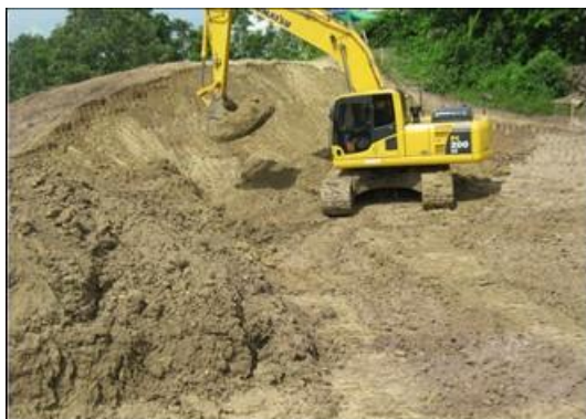
Foto 35. UMGP4. Excavación de segunda capa 30-60 cm. N06,48673° y W74,42040°
