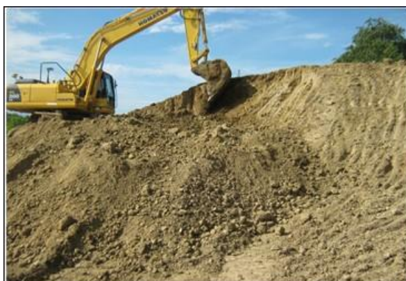
Foto 38. UMGP4. Aplanamiento final. N06,48685° y W74,42041°
