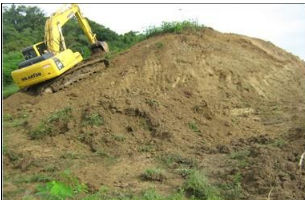
Foto 15. Proceso de descapote en UMGP3. Coordenadas N06,48674° y W74,42085°
