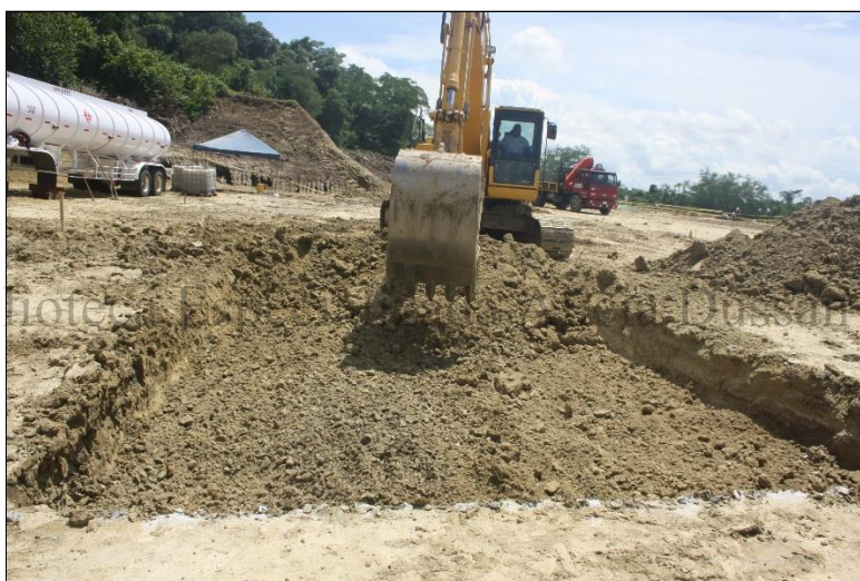
Foto 80. Excavación cimientos oficinas N06,48630° y W74,42058°
