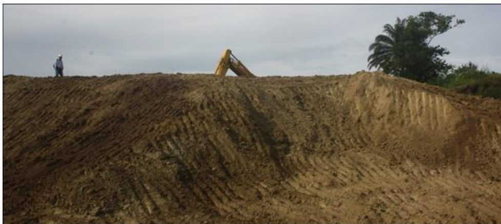
Foto 21. Revisión de superficies UMGP3 Coordenadas N06,48645 y W74,42051
