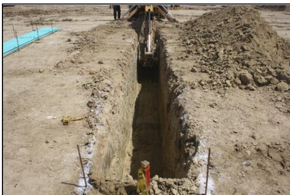
Foto 78. excavación zanja de ductos 1 N06,48649° y W74,42062°
