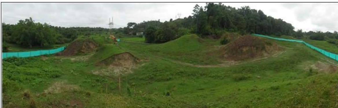
Foto 1. Vista parcial del predio donde se construyó la estación La Malena en dirección sur-norte, previa a la intervención. El lote está demarcado por la polisombra verde. (La foto fue capturada el 5 de agosto de 2016)
