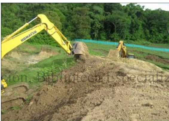
Foto 17. Proceso de descapote en UMGP3. Coordenadas N06,48644° y W74,42043°
