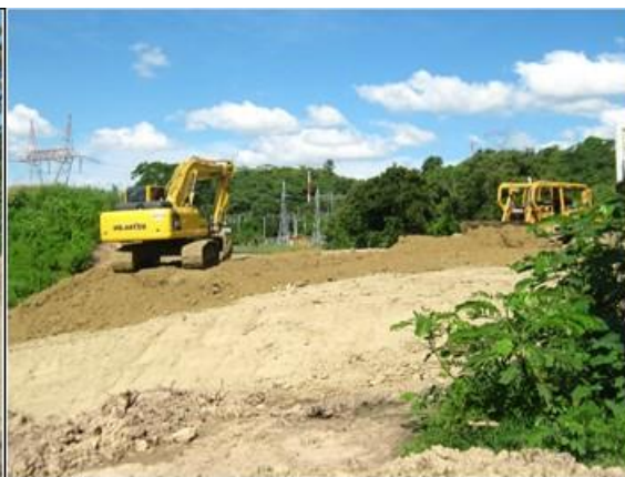
Foto 56. UMGP6 Aplicando el relleno de gravilla N06,48694° y W74,42086°
