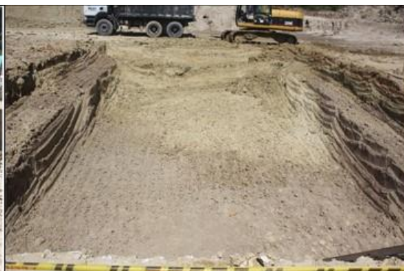
Foto 73. excavación base 1 de compresor N06,48606° y W74,42024°
