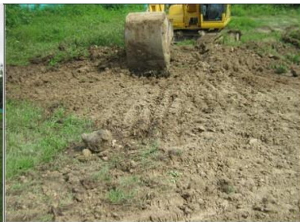
Foto 42. UMGP5 Remoción de capa húmica N06,48682° y W74,42129°
