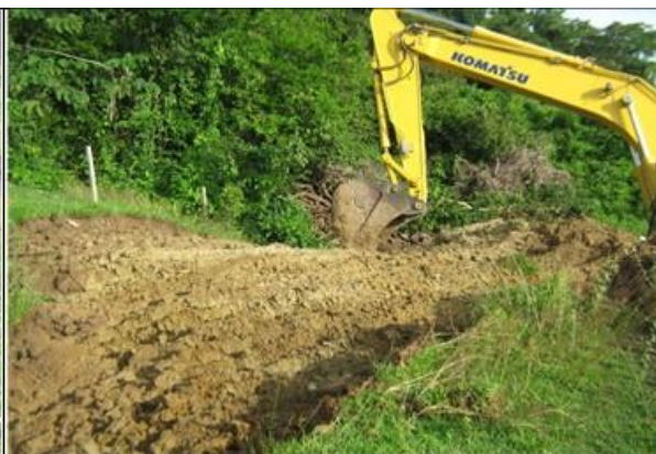
Foto 28. UMGP4. Inicio del descapote Coordenadas N06,48672 y W74,42027
