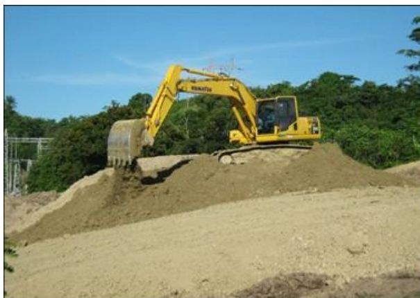
Foto 55. UMGP6 Aplanamiento final N06,48694° y W74,42086°
