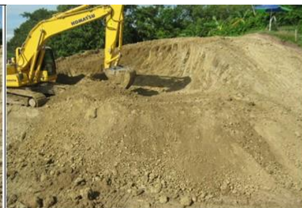
Foto 39. UMGP4. Aplanamiento final. N06,48685° y W74,42041°
