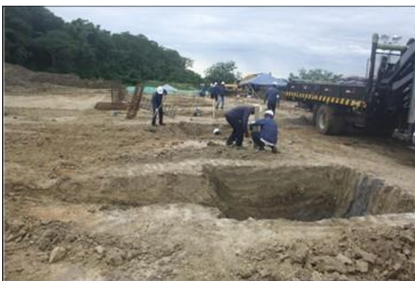
Foto 76. excavación bases para tubería N06,48636° y W74,42081°
