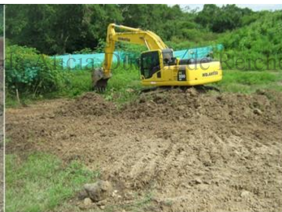
Foto 44. UMGP5 Remoción de capa húmica N06,48672° y W74,42131°
