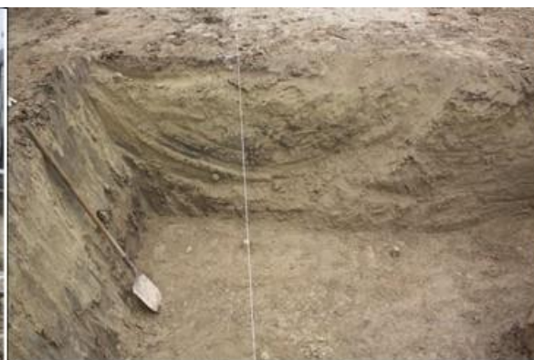
Foto 77. excavación bases para tubería N06,48623° y W74,42065°
