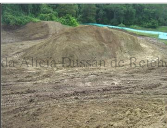
Foto 23. UMGP3 Retirada de segunda capa de 30 cm Coordenadas N06,48648° y W74,42064°
