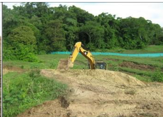
Foto 16. Proceso de descapote en UMGP3. Coordenadas N06,48644° y W74,42043°
