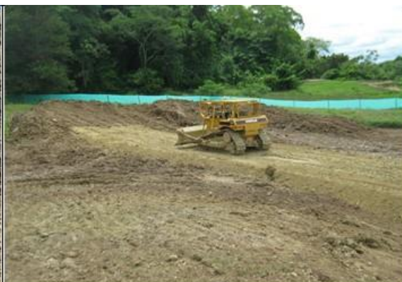
Foto 9. Proceso de relleno en UMGP2 Coordenadas N06,48599° y W74,42006°
