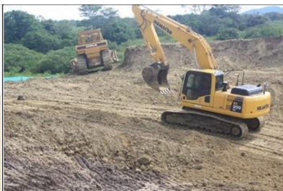
Foto 25. UMGP3 Actividad de aplanamiento final Coordenadas N06,48648° y W74,42064°
