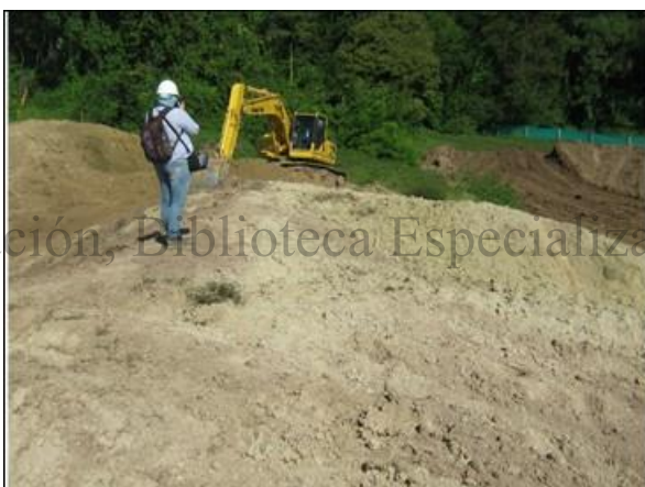
Foto 22. UMGP3 Retirada de segunda capa de 30 cm Coordenadas N06,48648° y W74,42064°
