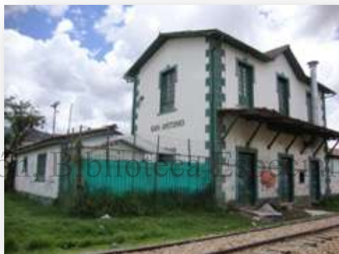
Figura 11. Estación de San Antonio que dependía de la estación de Usaquén. Por su disposición se puede pensar en una estación de carga. En la actualidad es una casa ocupada.
