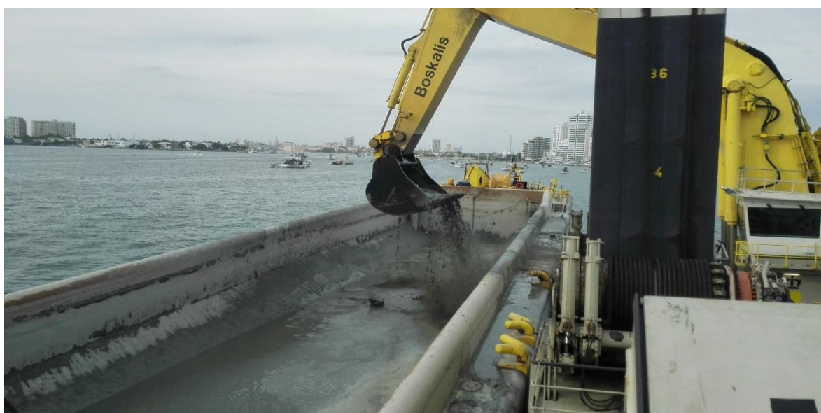
Figura 1. Supervisión arqueológica de operación de dragado mediante pala mecánica. SPRC, Cartagena de Indias Enero 2017. Fuente propia.
