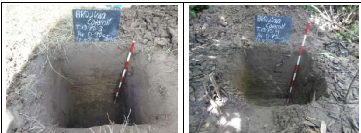
Fotografía 5-35. Perfiles pozos de sondeos realizados en el sitio de torre 13
