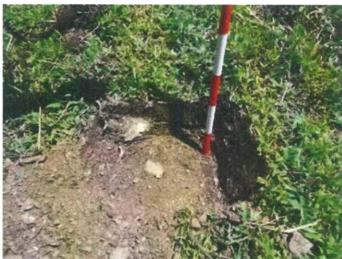
Fotografía 4.37 Pozo de prueba en el escalón 1.
