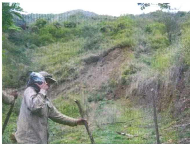
Fotografía 1.4 Desgarres superficiales en el corte vial de la vía de acceso al predio.
