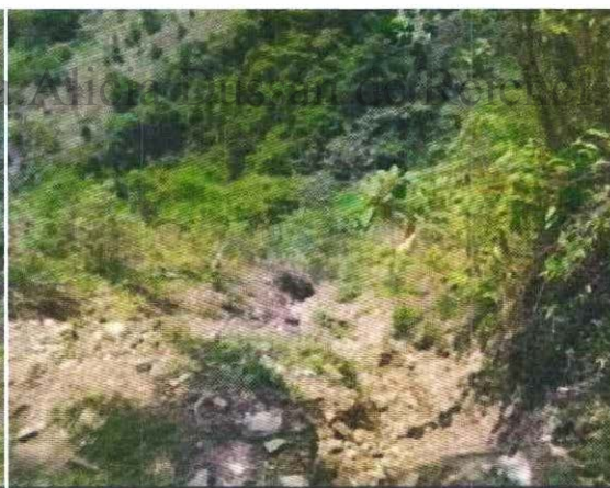
Fotografía 1.3 Fenómeno de inestabilidad.
