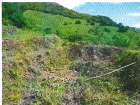
Fotografía 4.24 Excavación de estanque UIA 2.
