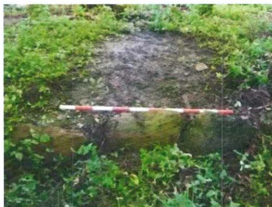
Fotografía 4.25 Piso en cemento con muro UIA 2.
