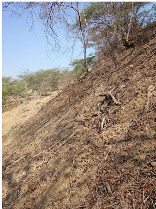
Fotografía 19 Revisiones de perfiles debido a estar en un lugar inclinado
