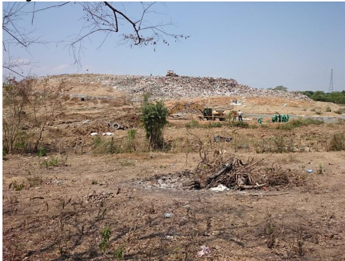
Fotografía 2 Relleno sanitario a escasos metros del área de estudio
