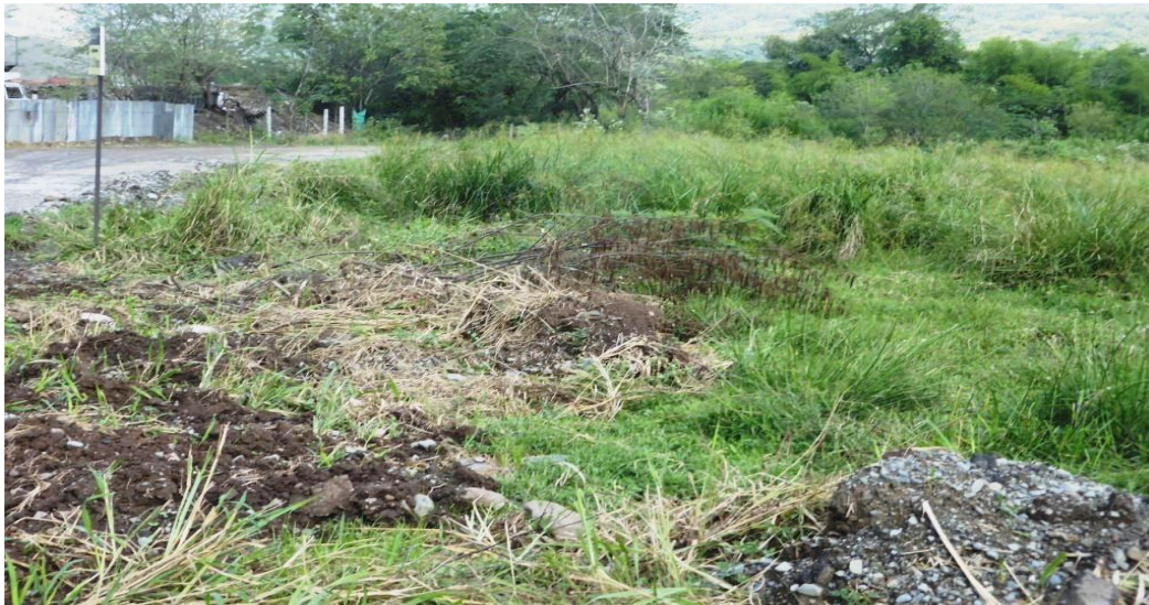
FOTO 23 . CONSTRUCCIÓN DE CUNETAS CON FILTROS EN EL SECTOR BAJO DEL ÁREA: 3
