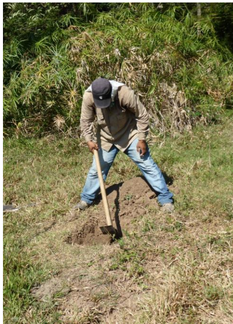
FOTO 30. EXCAVACIÓN DE POZO DE SONDEO EN EL ÁREA: 5. UMA: 5
