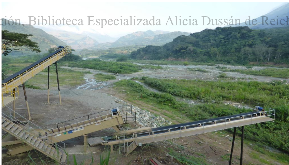
FOTO 4. ÁREA DE EXPLOTACIÓN E INFRAESTRUCTURAS DEL TÍTULO MINERO LMF - 08051
