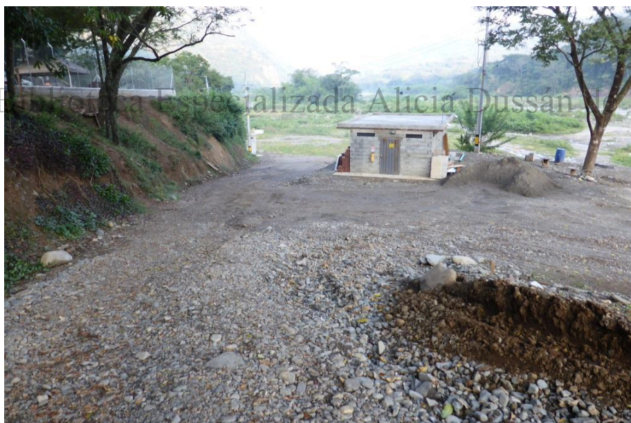
FOTO 8. VISTA GENERAL DEL ESTADO ACTÚAL DE LA TERRAZA 2 EN EL ÁREA 1
