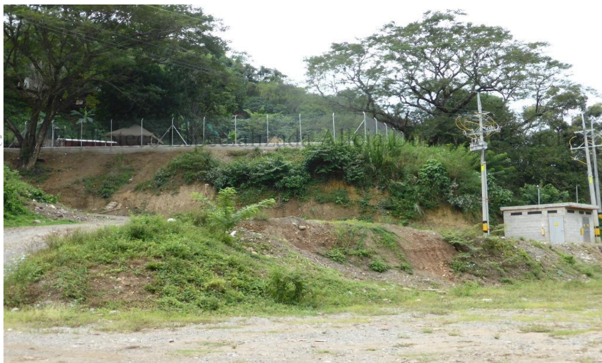
FOTO 10. NIVEL DE LOS TALUDES DESPUÉS DE LAS EXPLOTACIONES EN EL ÁREA 1
