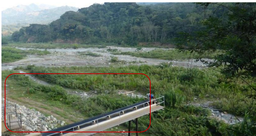
FOTO 9. VISTA GENERAL DEL ESTADO ACTÚAL DE LA TERRAZA: 3 EN EL ÁREA: 1
