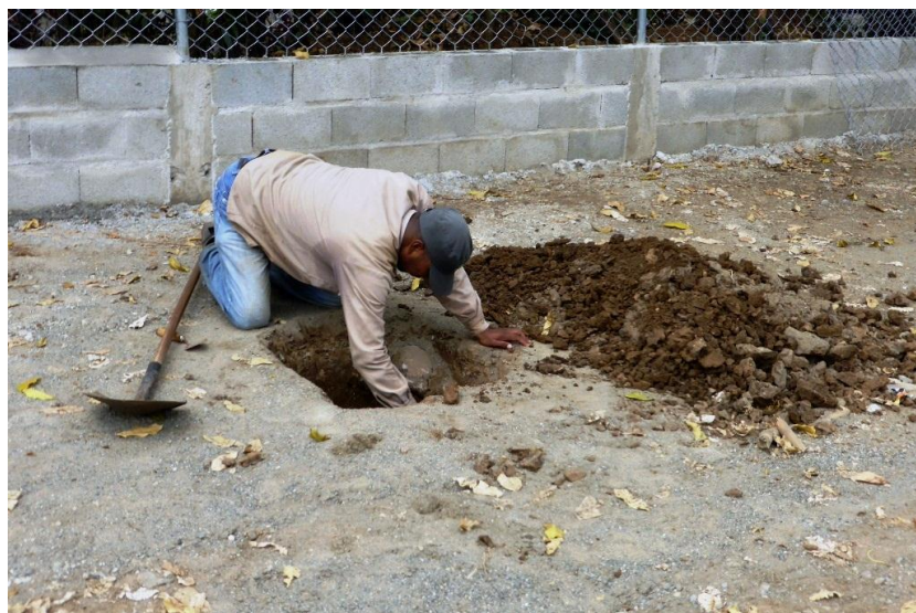
FOTO 18. EXCAVACIÓN DE POZO DE SONDEO: 7 EN EL ÁREA: 2
