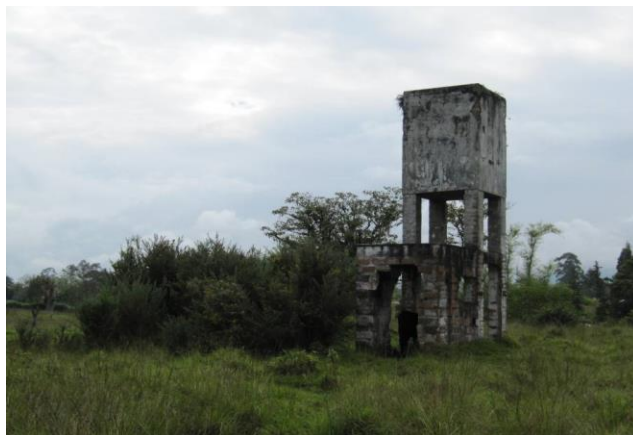
Fotografía 5. Ruinas de tanque en el predio La Paz.
