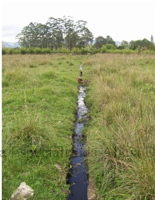
Fotografía 14. Acequia revestida en concreto que atraviesa todo el sector Noroccidental del predio.
