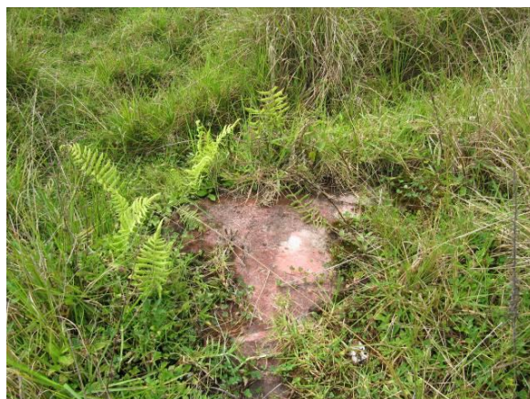
Fotografía 13. Ruinas del piso de la casa en loza de concreto.
