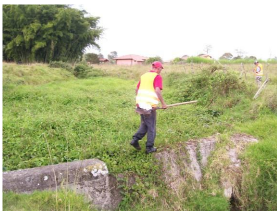
Fotografía 15. Dique de concreto ubicado en el centro del canal artificial.
