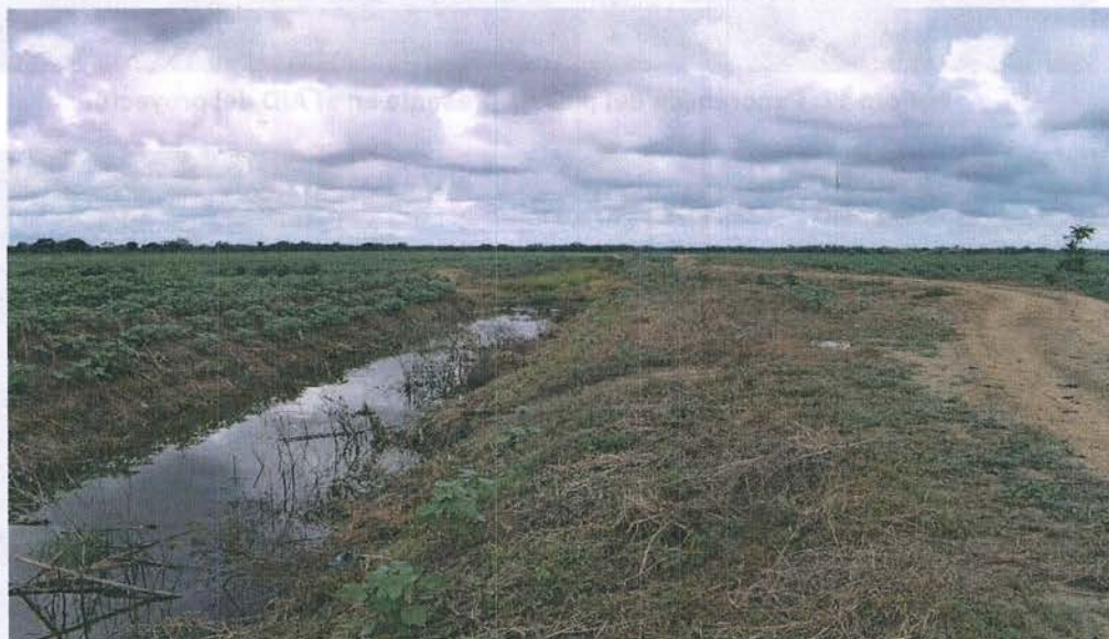
Foto 21. Área con intervención por construcción de vía y remoción de suelo para canalización de drenaje y riego.
