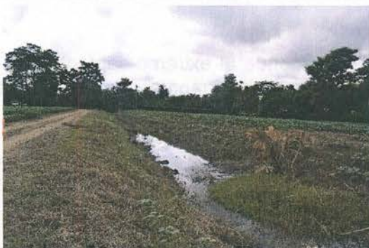
Foto 10. Visualización de los canales para desagüe y mitigar inundación.
