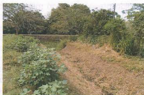
Foto 30. Zona de Fin de Tramo 3.
