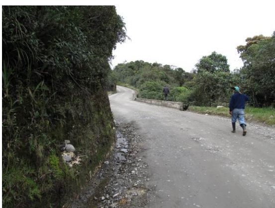
Fotografía 4. Taludes y cortes en los que se enmarca el trazado de la vía.
