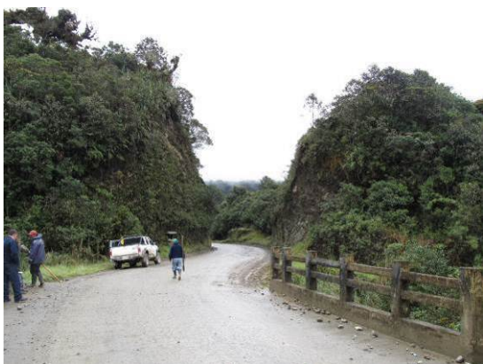
Fotografía 13. Áreas de escarpe y fuerte pendiente.
