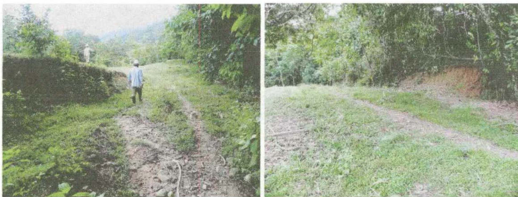
Foto N° 8. Municipio de Cimitarra, vereda La Verde. Vía de acceso proyectada a Opón Sur 1. Esta seguirá en la mayor parte de su trazado el acceso a una locación antigua.
