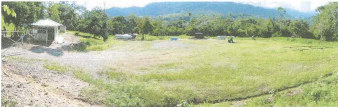
Foto N° 24. Antiguo pozo Lilia 5, en este terreno se adecuara la locación Angie 1.
