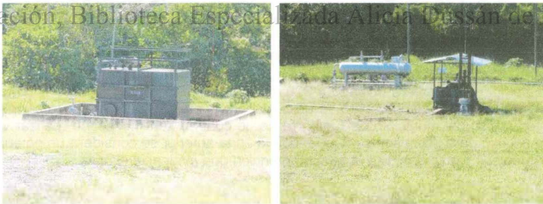
Foto N° 25. Adecuaciones de la antigua locación Lilia 5.
