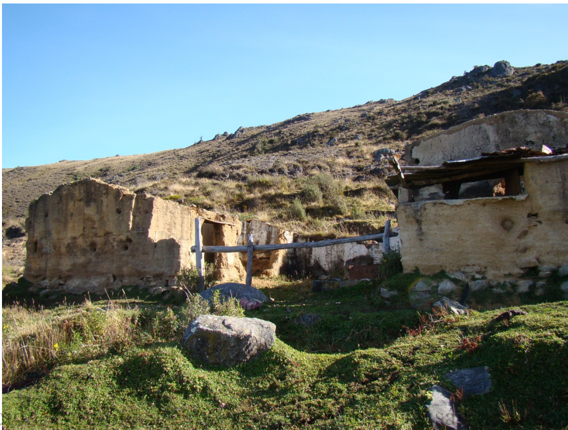
Figura 13: Casa abandonada de la antigua finca Termopilas y que se haya sobre el trazado de la vía.
