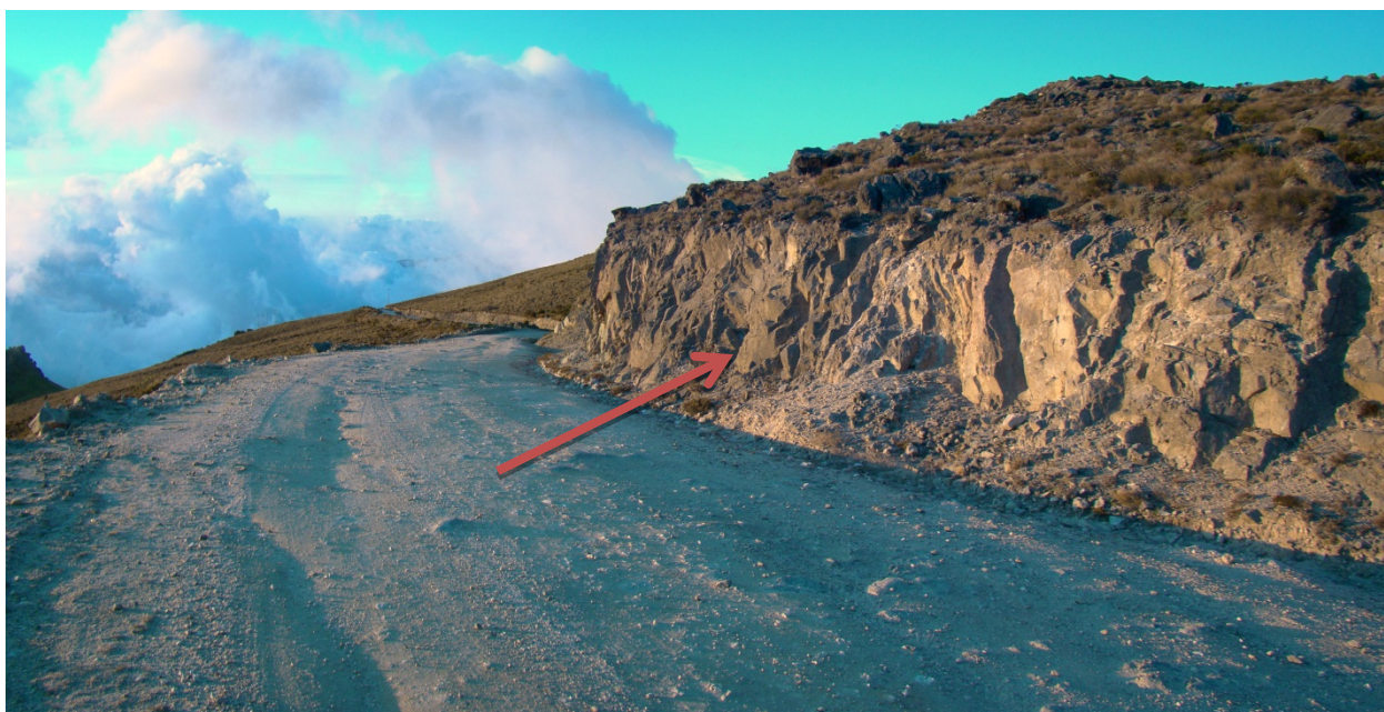
Figura 2: Perfil expuesto en el recorrido de la vía Berlín Vetas. Nótese la capa de roca en todo el perfil.
