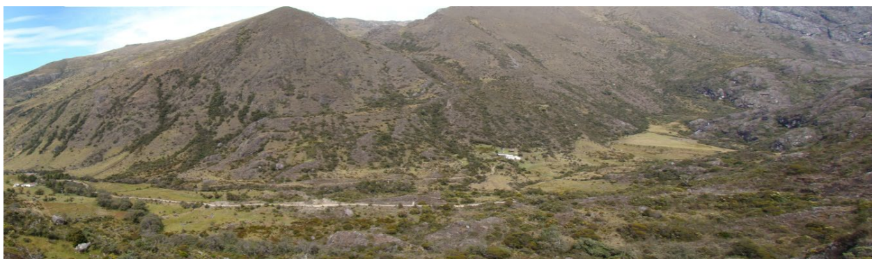
Figura 18: Vista general del valle por donde pasa la actual quebrada El Salado. Allí se tiene proyectado la construcción de un embalse.
