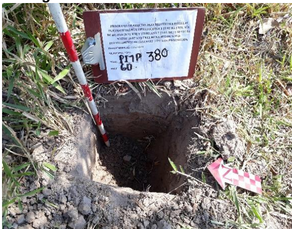
Fotografía 16. Pozo de sondeo PI1P380
