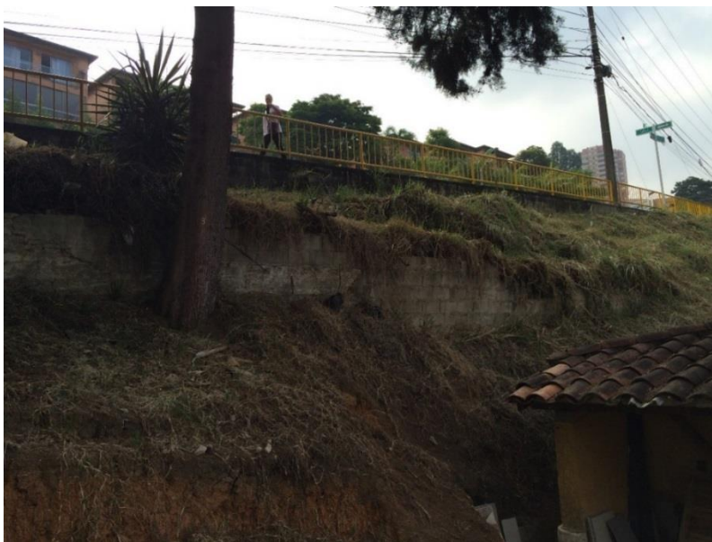
Foto 34. Área intervenida antes del comienzo del Proyecto Inmobiliario Ámsterdam, donde se observa el muro en bloques de concreto que posiblemente delimitaba el área de la antigua finca, y que ahora ocupa el predio del proyecto inmobiliario después de la ampliación de la Transversal Superior y la construcción del viaducto para el andén.
