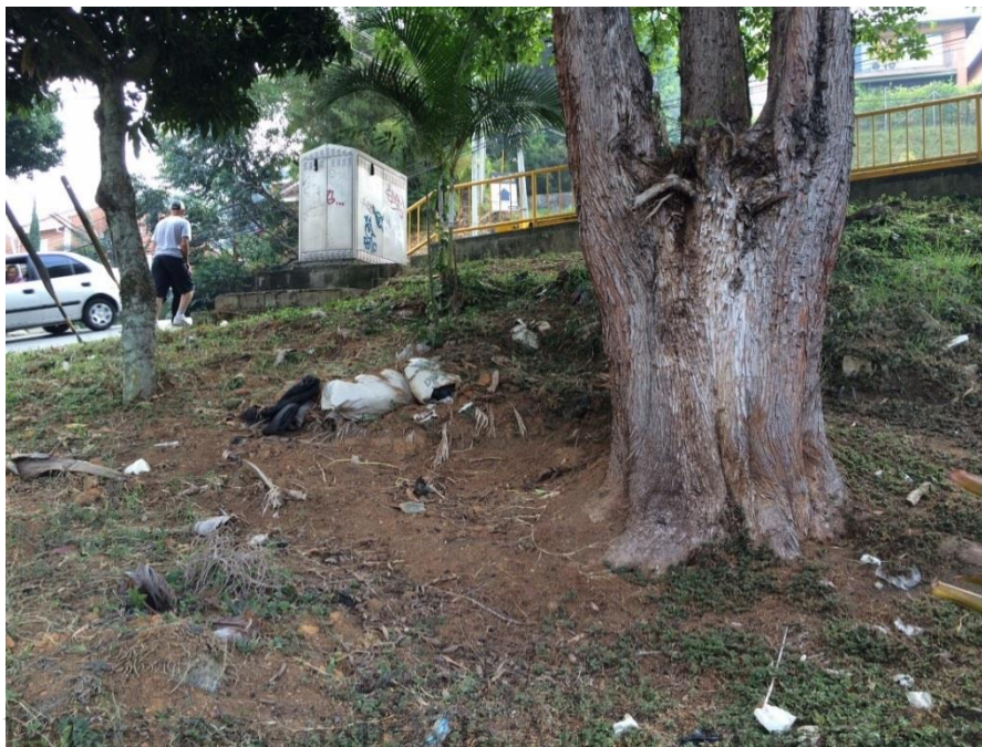
Foto 35. Sector oriental del predio, que ha sido intervenido antes de la llegada del Proyecto Inmobiliario Ámsterdam, por la instalación de una caja de energía ubicada en las cotas superiores del predio, cerca de la Transversal Superior del barrio El Poblado.
