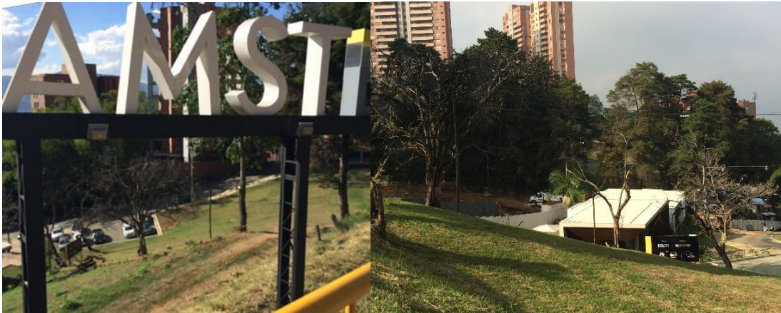
Fotos 67 y 68. En las fotos se observa la inclinación de la pendiente que presenta el Sector 1 del Proyecto Inmobiliario Ámsterdam.
