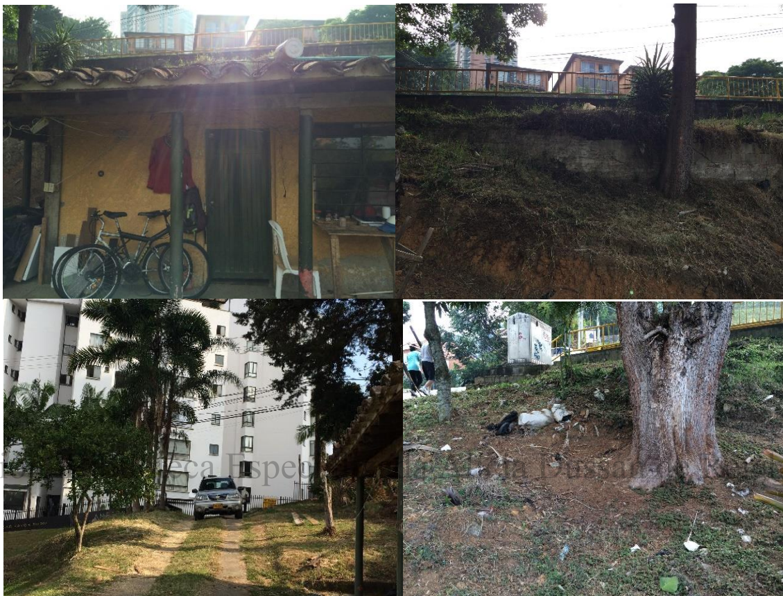
Fotos 63, 64, 65 y 66. Vista de la cota superior del Sector 1 donde se encuentra la portería de la antigua finca, parte de un muro antiguo hecho de adobes de concreto, la vía de acceso en rieles de concreto, y las basuras dispuestas en varios sectores del lote.
