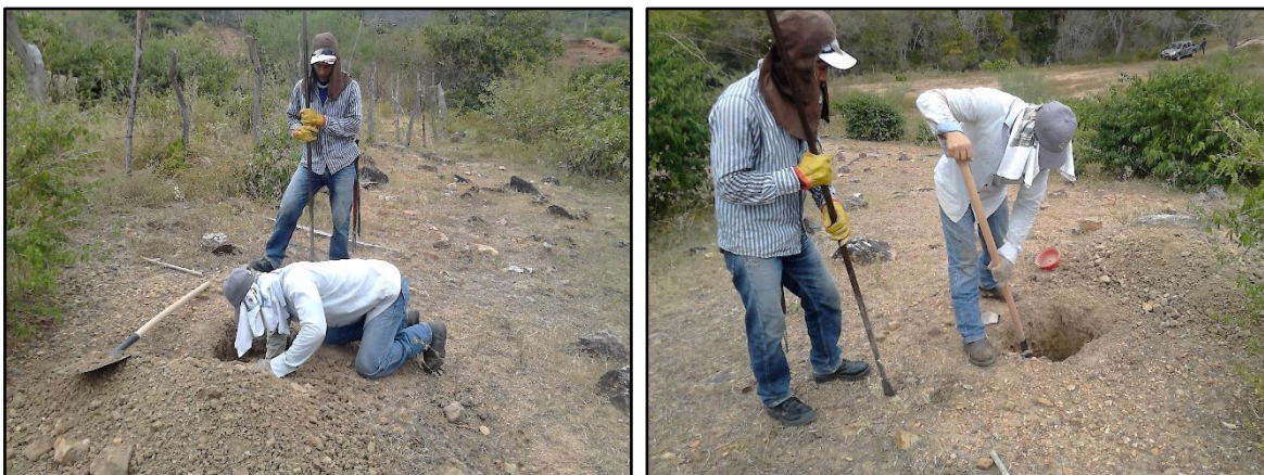
Foto 14 a 15. Realización pozos de sondeo área de zodme-campamento.
