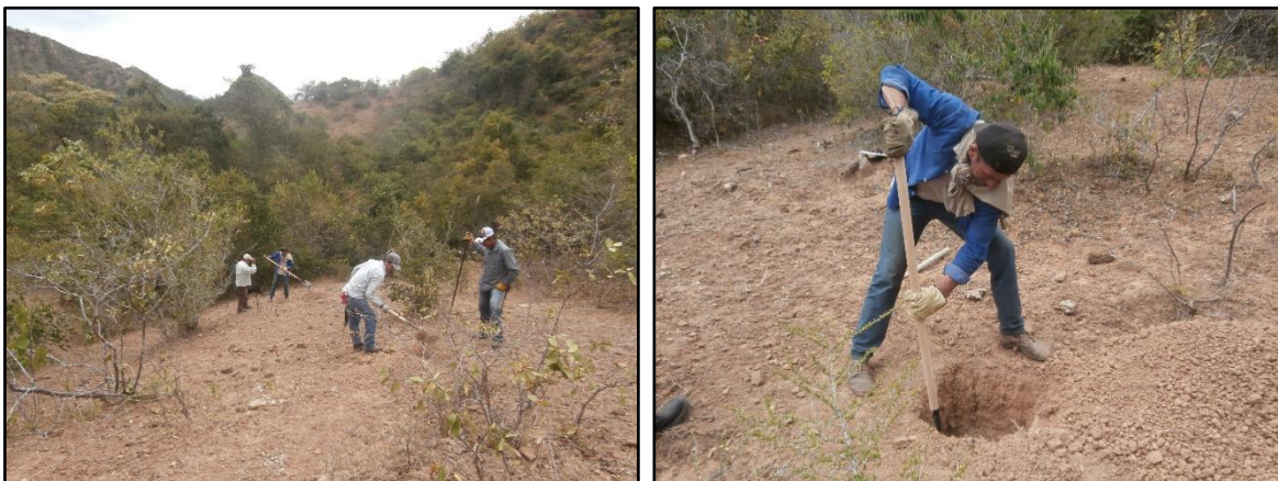
Foto 6 a 13. Estacado, distanciamiento y realización de sondeos en área de plataforma.
