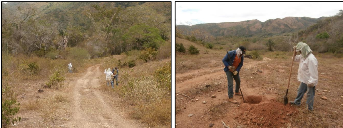
Foto 17 y 18. Realización pozos de sondeo vía de acceso.
