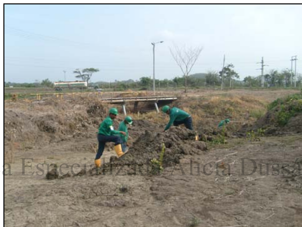
Foto 20. Revisión de terrenos removidos junto al Arroyo Grande, sector sur del Lote 1.
