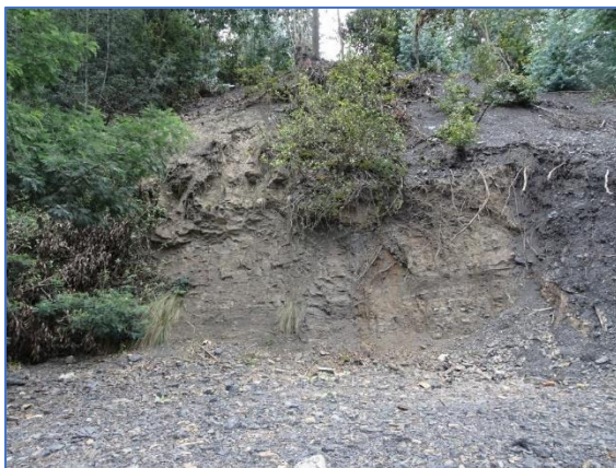
Fotos N°55 y 56. Corte de talud con areniscas en matriz arcillosa. Descenso hacia la tolva y área de carga.
