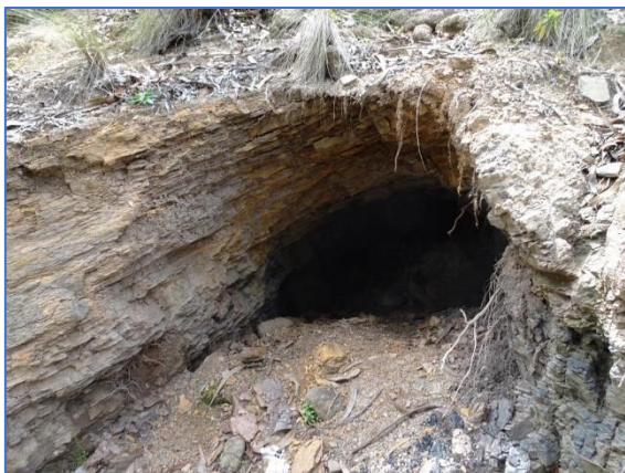
Fotos N°91 y 92. Antigua bocamina en derrumbe. Corte de perfil donde se aprecia una delgada capa orgánica debido a la escarpada topografía.
