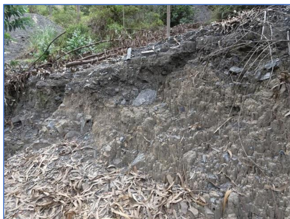
Fotos N°77 y 78. Camino interno entre la mina. Perfil con areniscas y arcillas.
