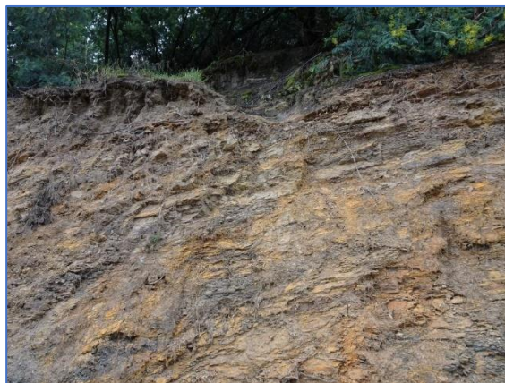
Fotos N°43 y 44. Ladera en recuperación. Corte de talud con afloramientos de arenisca.
