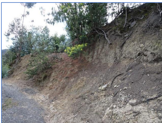
Fotos N°23 y 24. Vía con corte de talud donde se observan las areniscas incrustadas en una matriz arcillosa.
