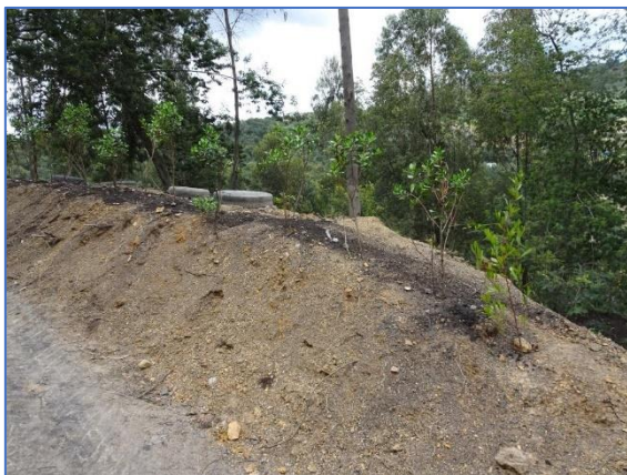
Fotos N°43 y 44. Ladera en recuperación. Corte de talud con afloramientos de arenisca.
