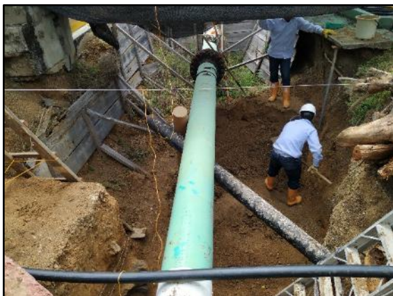
Fotografía 19. Actividades de remoción del suelo en el área de la obra
