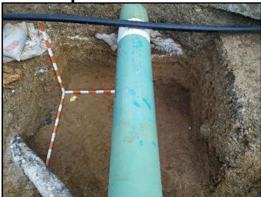
Fotografía 10. Excavación a los 155 cm de profundidad alterado
