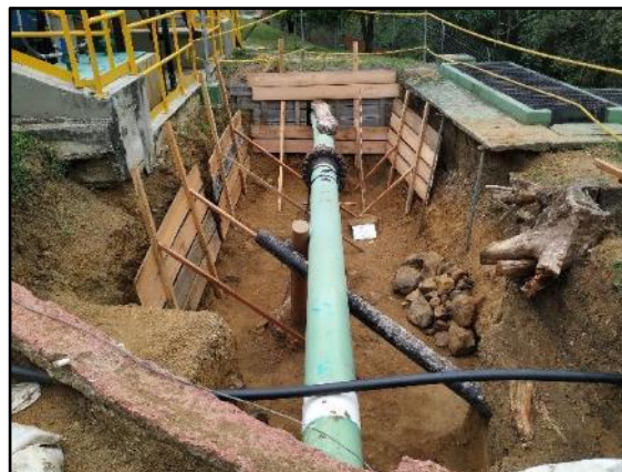
Fotografía 20. Planta final de la obra, ubicada entre 2,45 – 2,5 m.
