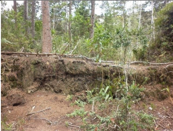
Foto 7. Canal con muro a un lado (en tierra)
