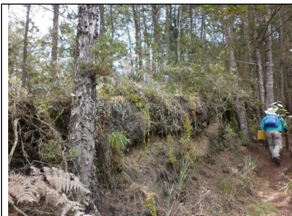
Foto 9. Canal con muro a un lado (en tierra)
