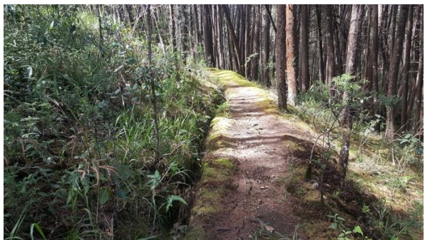
Foto 31. Acequia para conducción de agua.
