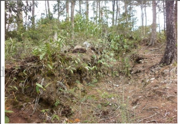
Foto 8. Canal con muro a un lado (en tierra)
