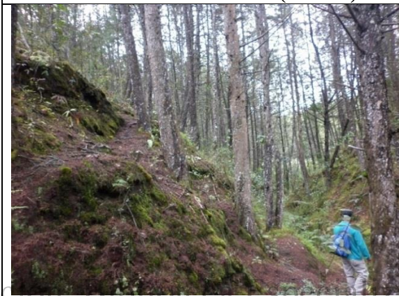
Foto 11. Cortes en ladera (cárcava)
