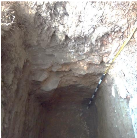
Fotografía 6-11. Cimentación en roca- costado norte Corte 2.
