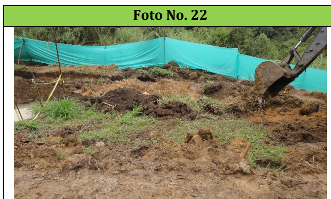
Descripción: inicio de descapote tramo 6
