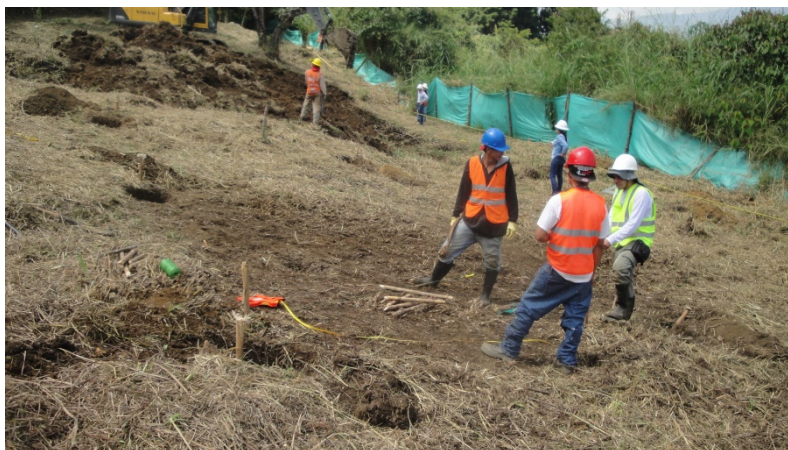
FOTO 6. DEMARCACIÓN Y REALIZACIÓN DEL CORTE DE EXCAVACIÓN
