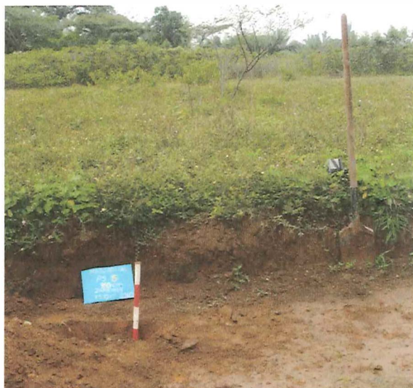
Foto 6. Pozo de sondeo 5, en sector oriental del lote, aprovechando las adecuaciones para vías.
