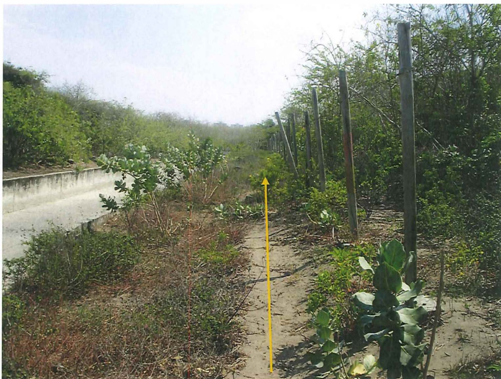
FOTO 5. TRAZADO DE LA TUBERÍA SOBRE DEPÓSITOS ALUVIALES RECIENTES DE ARENA
