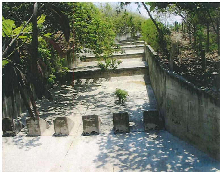
FOTO 4. OBRAS DE CANALIZACIÓN DE CAÑO
