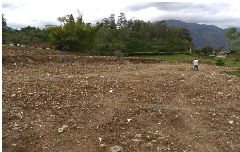
FOTO 1. PANORAMICA GENERAL DEL AREA DEL PROYECTO
