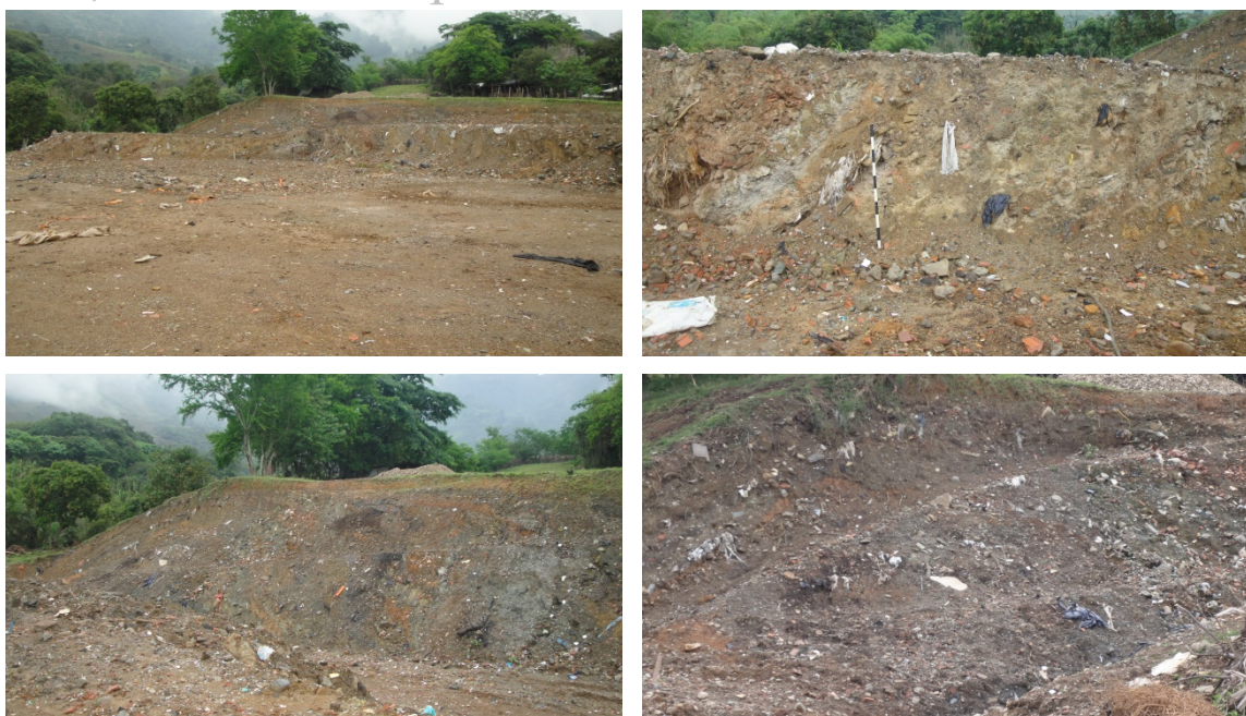
FOTO 3. SUELOS EXPUESTOS – TALUD DE LLENOS ANTROPICOS (ESCOMBRERA)
