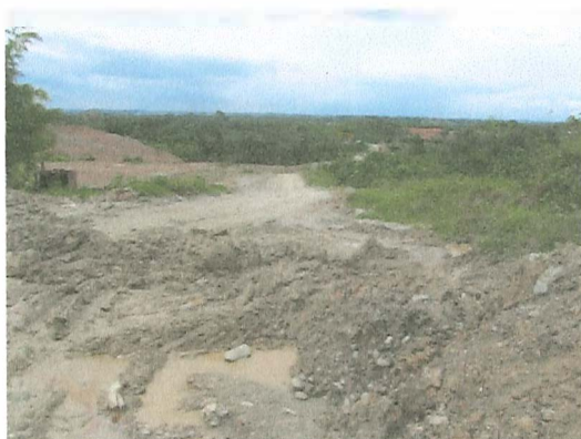
Ilustración 1: Movimiento de tierra para construcción de urbanización
