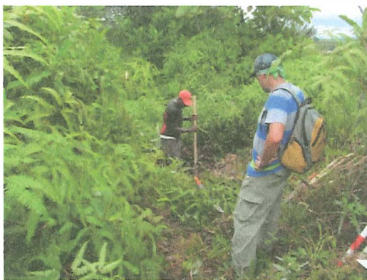
Ilustración 7: Pozos de sondeo a lo largo de la vía existente Curva del Diablo-Campo Hermoso
