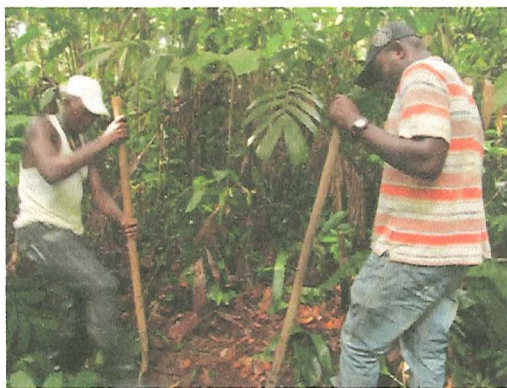
Ilustración 8: Pozos de sondeo a lo largo de la vía existente Curva del Diablo-Campo Hermoso
