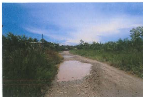
Fotografía 35 Vía en la vereda La Esmeralda
