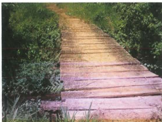
Fotografía 23 Puente sobre la quebrada La Peinilla
