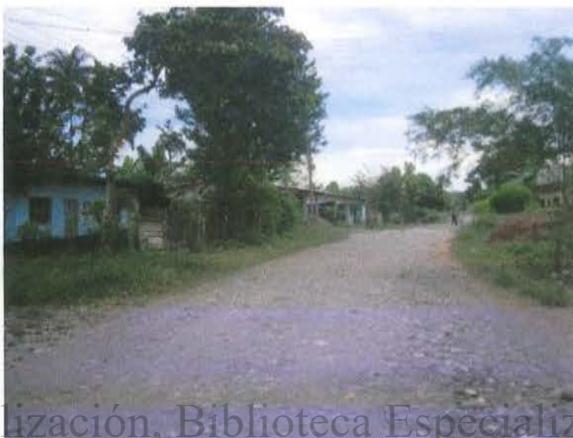
Fotografía 4 Vista del corregimiento del Tigre, Municipio del Valle del Guamuez. Inicio del trazado.
