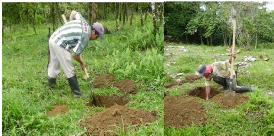
FOTO 8. EXCAVACIÓN DE SONDEOS EN LA UMG. 1
