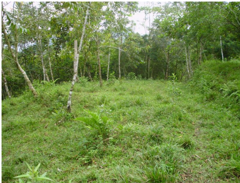
FOTO 6. ATERRAZAMIENTOS CONSTRUIDOS RECIENTEMENTE. ZONA INDUSTRIAL
