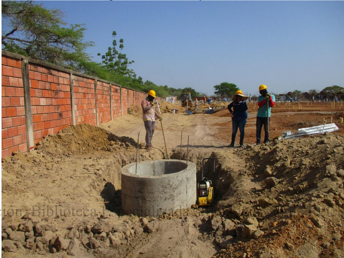
Fotografía 5 Instalación de cajas de conexión
