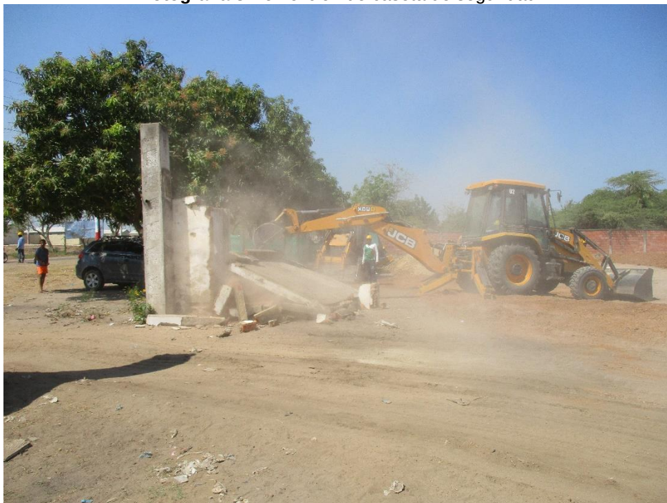
Fotografía 8 Demolición de caseta de seguridad
