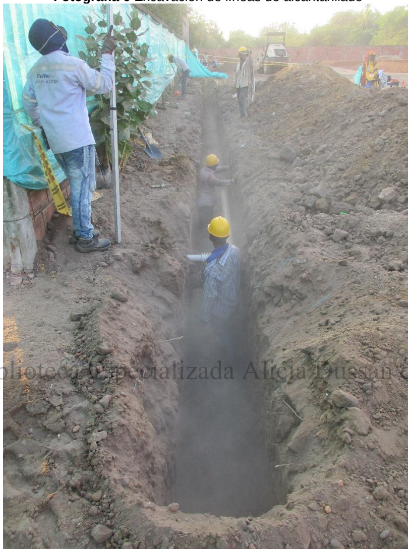
Fotografía 6 Excavación de líneas de alcantarillado
