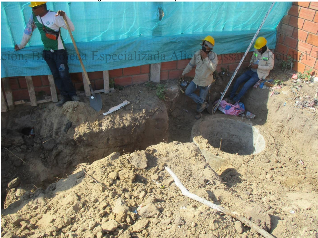
Fotografía 4 Instalación de cajas de conexión
