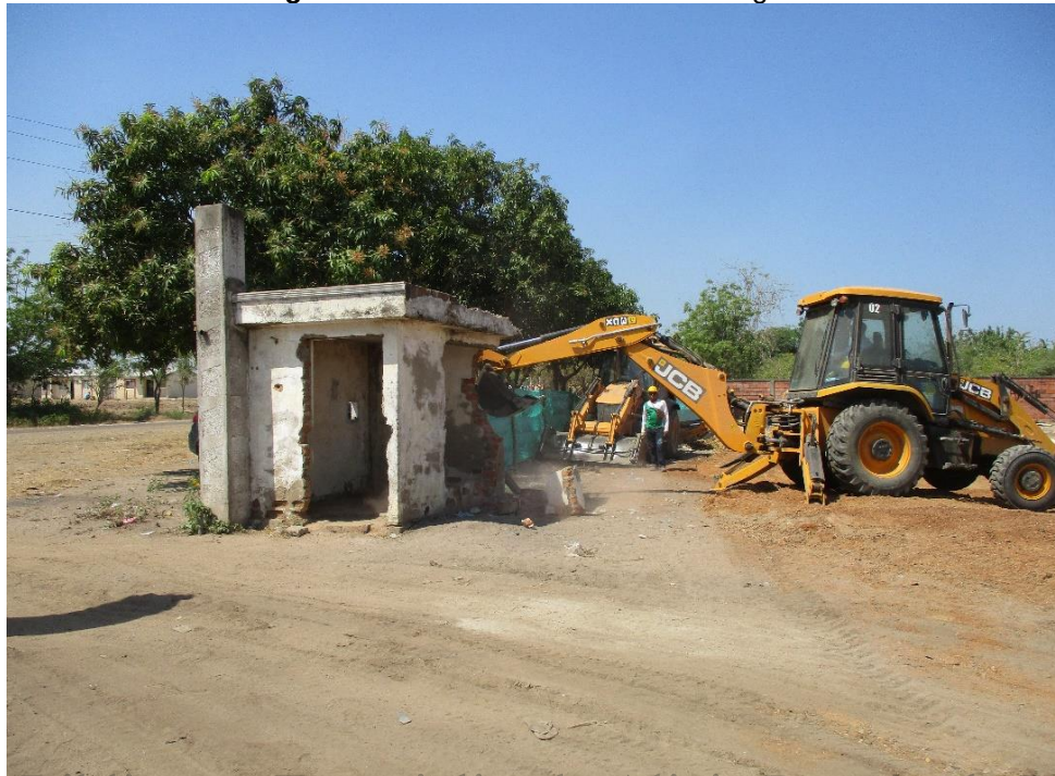
Fotografía 7 Demolición de caseta de seguridad
