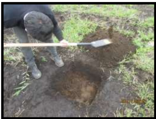
Figura 7 , marcación de pozos de sondeo. Figura 8 , profundidad aproximada de pozos de sondeo.
