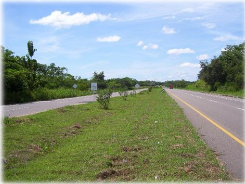
Imagen 5 Estado final de obras en Polígono 2
