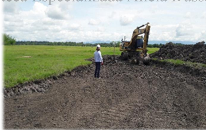
Imagen 13. Inspección visual detallada en actividades de descapote con buldócer del intercambiador vial en el Km 97+000
