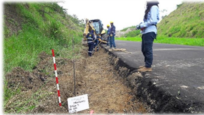
Imagen 14. Inspección visual de instalación de cunetas, Polígono 3 km 97+000
