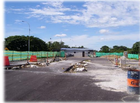
Imagen 6 Estado final de obras en Polígono 10
