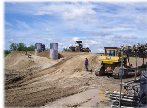
Imagen 4 Estado final del intercambiador vial
