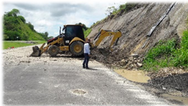
Imagen 15. Monitoreo de actividades de remoción Polígono 3 Km 119+100
